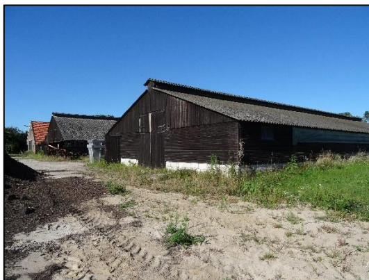
Fig. 2.3 Gebouw 1 (voorgond) en gebouw 2 (bron: FF Solutions)
