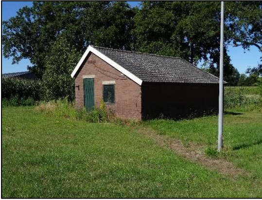
Fig. 2.19 Gebouw 5 (bron: FF Solutions)
