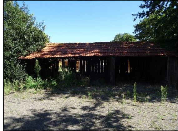
Fig. 2.28 Gebouw 9 (bron: FF Solutions)
