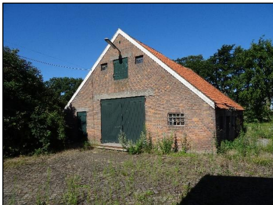
Fig. 2.11 Gebouw 3 (bron: FF Solutions)
