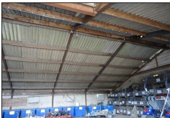
Fig. 2.41 Binnenzijde dak opslagplaats, gebouw 10 (bron: FF Solutions)
