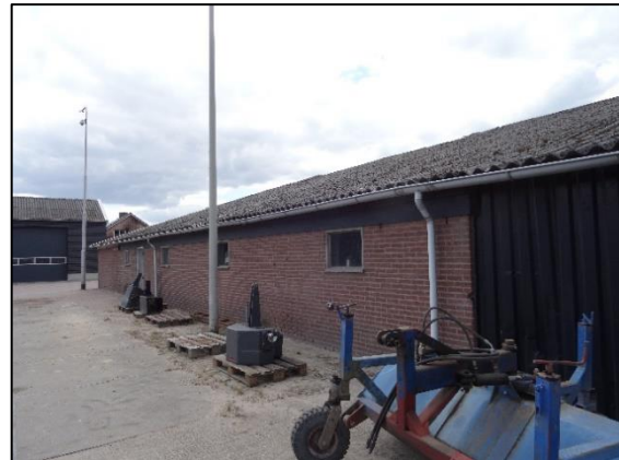
Fig. 2.38 Gebouw 10, zijkant (bron: FF Solutions)
