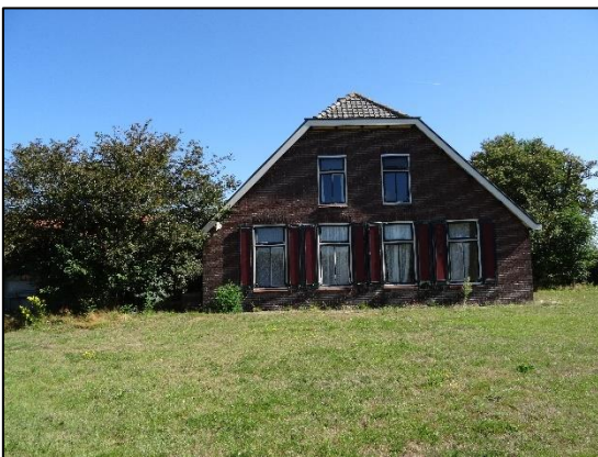
Fig. 2.23 Gebouw 7, voorzijde (bron: FF Solutions)
