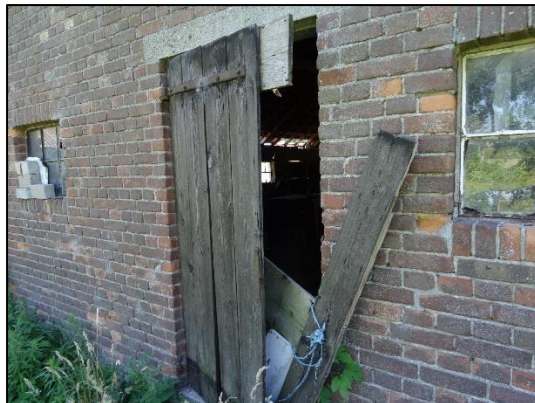
Fig. 2.12 Open deur, gebouw 3 (bron: FF Solutions)
