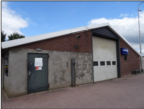
Fig. 2.37 Gebouw 10, voorzijde (bron: FF Solutions)
