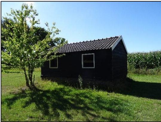
Fig. 2.21 Gebouw 6 (bron: FF Solutions)
