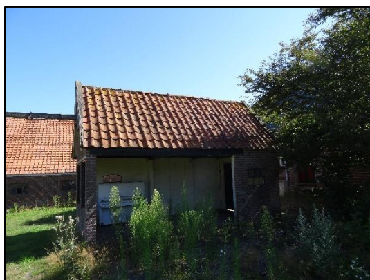
Fig. 2.16 Gebouw 4 (bron: FF Solutions)
