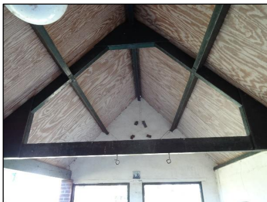
Fig. 2.17 Binnenzijde dak, gebouw 4 (bron: FF Solutions)
