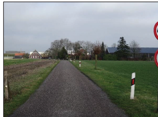
Fig. 2.5, Toegangsweg binnen projectlocatie (bron: FF Solutions)
