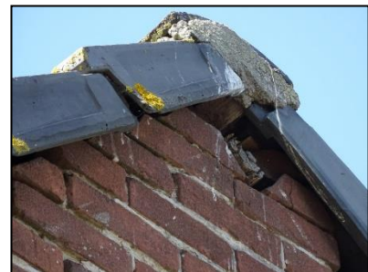
Figuur 39. Ruimte onder nokpan bij één van de schuren bij Doornsteeg 8.
