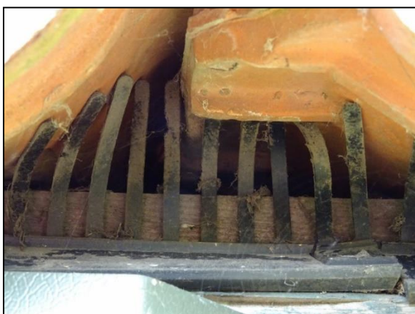
Figuur 34. Ruimte tussen dakplaten en gevel bij Doornsteeg 6 afgesloten voor vogels.
