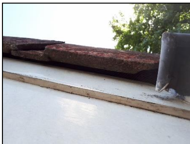
Figuur 37. Ruimte langs dakranden van woning bij Doornsteeg 8.
