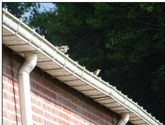
Figuur 33. Huismussen op dakgoot bij sta./schuur bij Doornsteeg 6.
