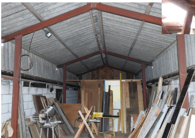
Niet-geïsoleerde golfplaat-constructie zonder spouwmuren biedt geen (permanente) verblijfplaats voor diersoorten. (12 juli 2021, M. van Leeuwen)
