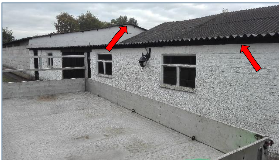
Foto 1. Golfplaten dak met mogelijke nestlocaties in de ruimte tussen de dak en de dakisolatie voor huismus en eventueel steenuil.
