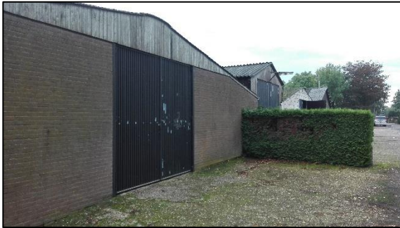
Foto 3. Noordzijde van de te slopen agrarische opstallen (zijde Amersfoortseweg) met gevelbetimmeringen.
