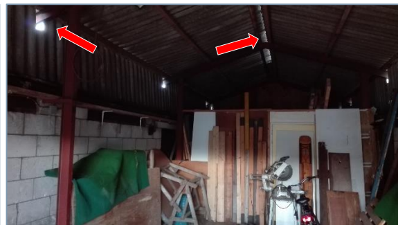
Foto 2. Openingen naar binnenruimte van één van de te slopen gebouwen: biedt toegang tot het gebouw voor huismus en steenuil.
