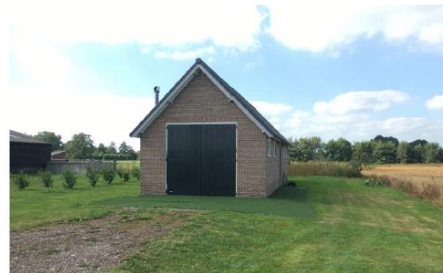
De bestaande schuilstal (jachthut)
