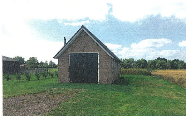
Foto 1. De bestaande schuifstal op het bouwblok aan de Van Dijkhuizenstraat 8 te Nijkerk
