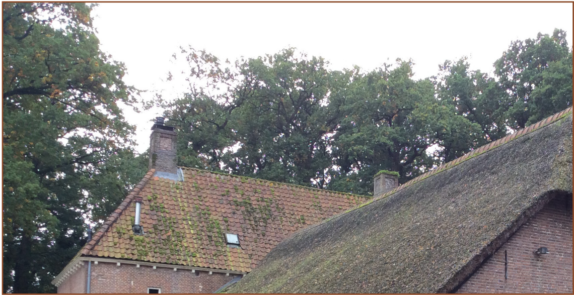
Afb. 2.1: Vooraanzicht te slopen woning.
