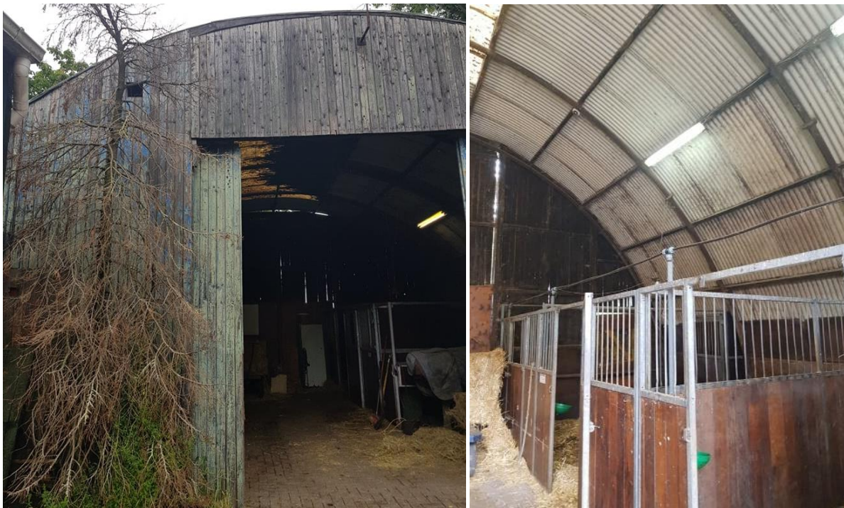
Figuur 10. Gebouw nummer 3. Houten betimmering met golfplaten dak.
