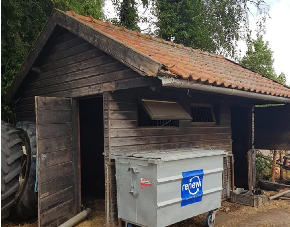
Figuur 12. Gebouw nummer 4. Houten betimmering met dakpannen.
