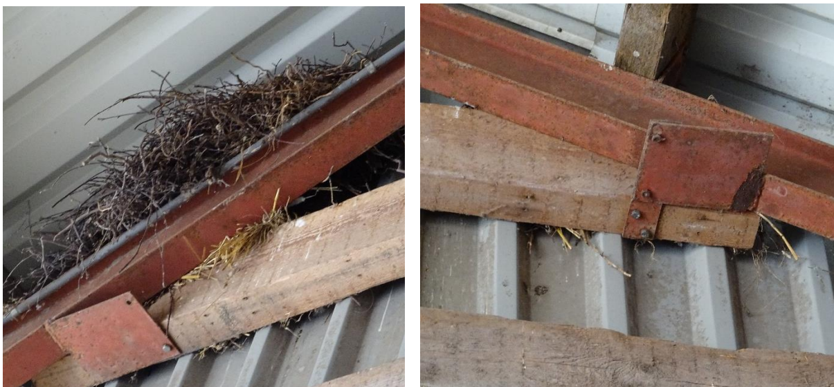
Figuur 9. Rechts: huismusnest tussen de balken onder een duivennest. Links: huismusnest achter de balken.
