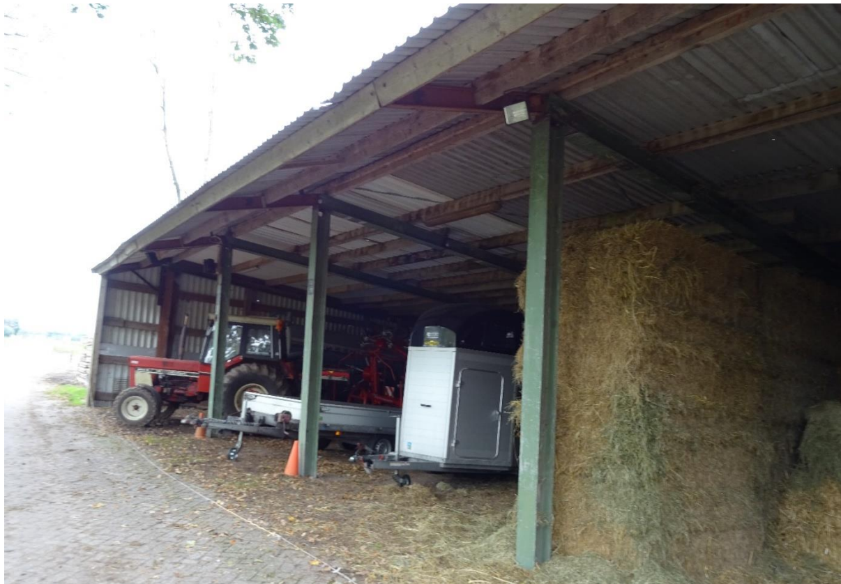
Figuur 7. Gebouw nummer 1. Metalen loods met golfplaten dak.
