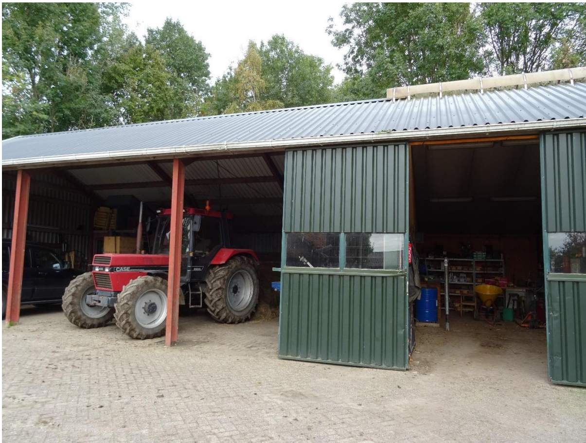
Figuur 8. Gebouw nummer 2. Metalen loods met golfplaten dak.
