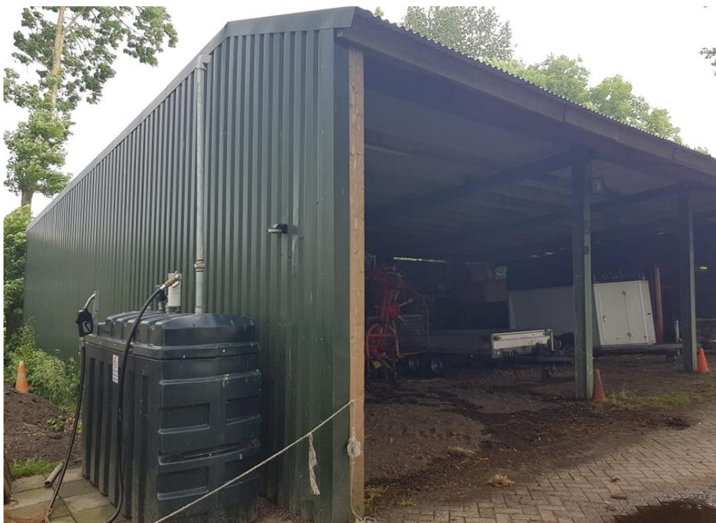
Figuur 8. Gebouw nummer 1. Metalen loods met golfplaten dak.
