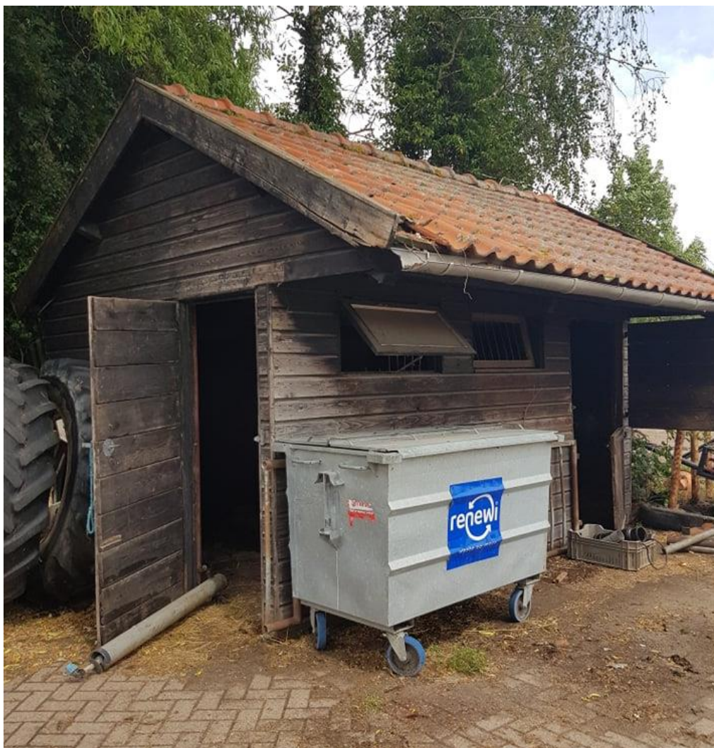
Figuur 14. Gebouw nummer 4. Houten betimmering met dakpannen.
