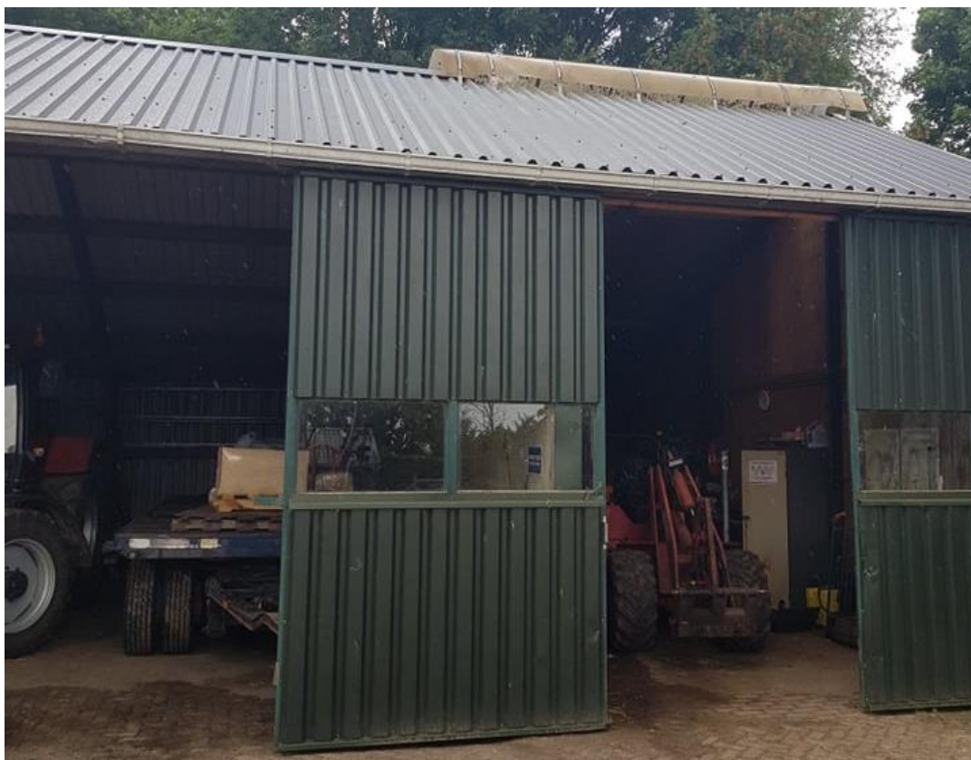
Figuur 10. Gebouw nummer 2. Metalen loods met golfplaten dak.
