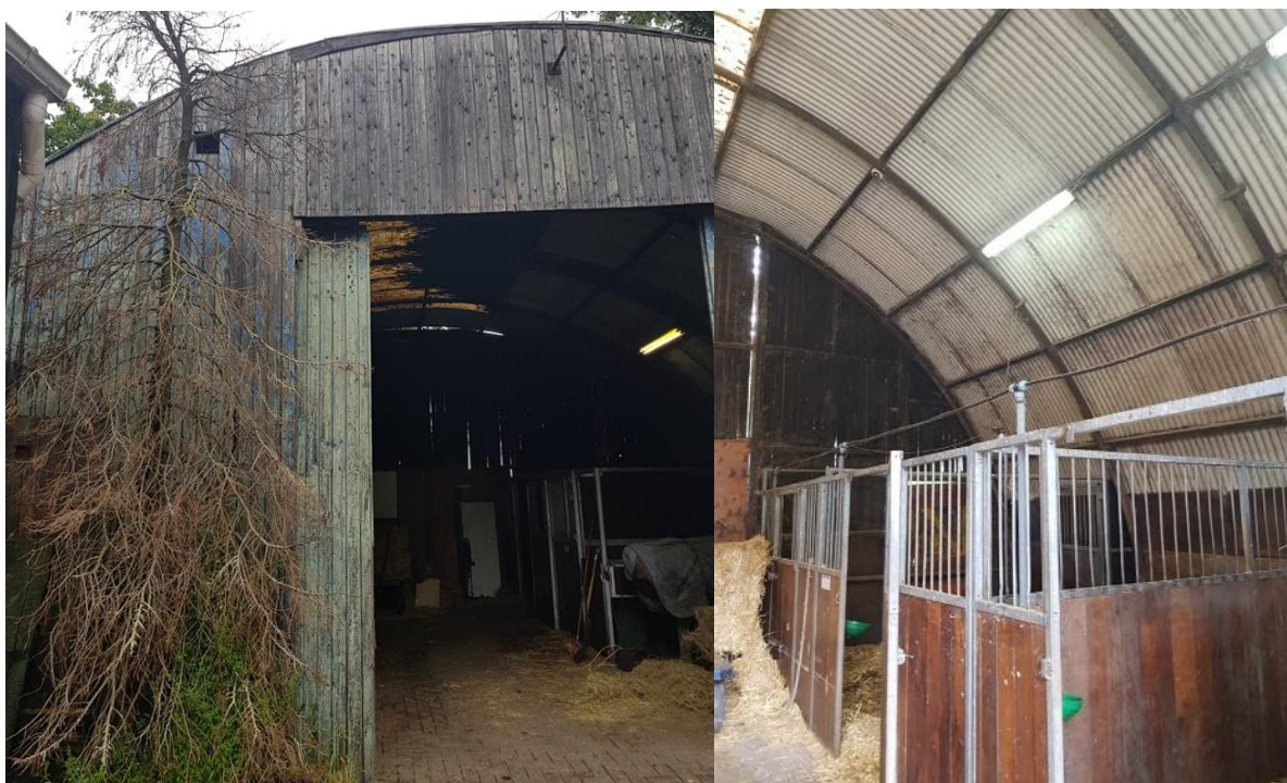
Figuur 12. Gebouw nummer 3. Houten betimmering met golfplaten dak.
