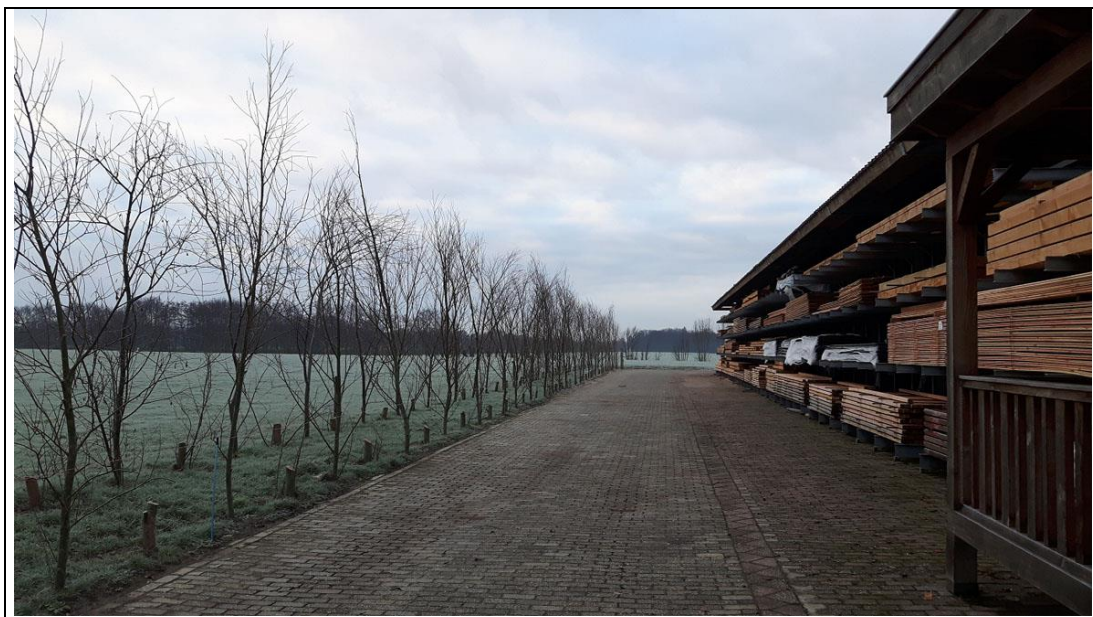
Afbeelding 8: Opslag van halffabricaten en groensingel in aanleg langs oostzijde van het perceel.
