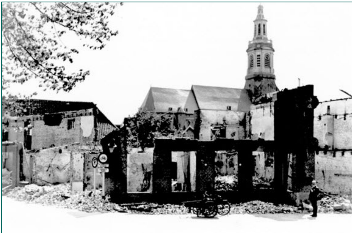
Figuur 3: schade door de artilleriebeschieting van 12/13 mei 1940. Hier te zien is de hoek Nieuwstraat/Verlaat met op de achtergrond de toren van de Hervormde Kerk. Bron: Evacuatie aan het begin van de oorlog: Mei 1940 , Mijn Gelderland, www.mijngelderland.nl .
