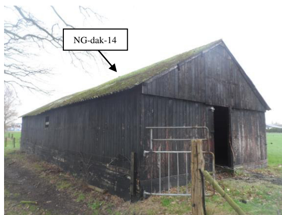
Foto 40: Geïntervieweerde schuur 12 met asbesthoudende golfplaat als dakbedekking vanuit zuidoostelijke richting gezien.
