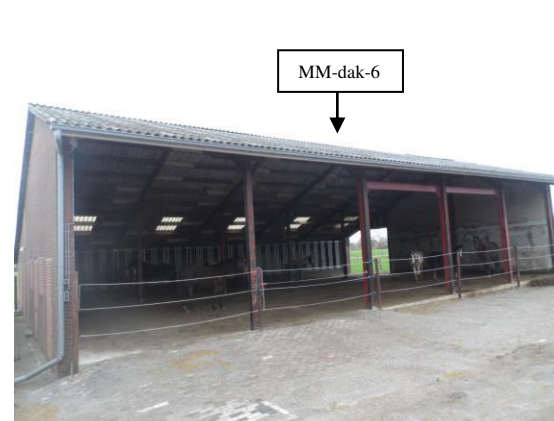
Foto 18: Geïntervieweerde schuur 4 met asbesthoudende golfplaat als dakbedekking vanuit noordelijke richting gezien.
