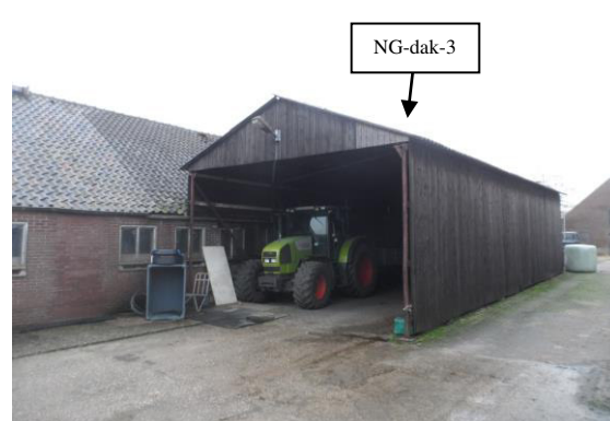
Foto 24: Geïntervieweerde schuur 5 met gedeeltelijk asbesthoudende golfplaat als dakbedekking vanuit noordwestelijke richting gezien.
