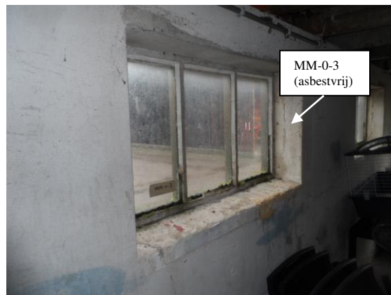
Foto 8: Asbestvrije stopverf in/aan raamkozijnen van schuur 1.
