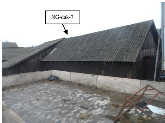
Foto 31: Geïntervieweerde schuur 8 met asbesthoudende golfplaat als dakbedekking vanuit westelijke richting gezien.
