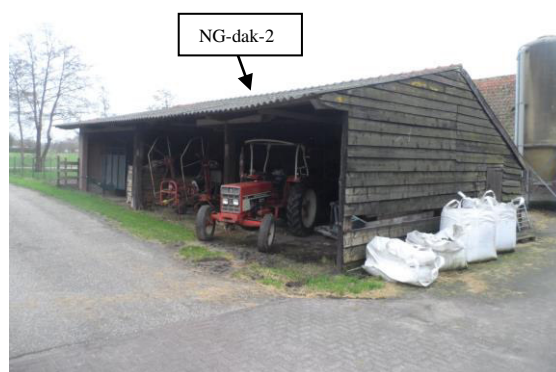
Foto 12: Geïventariseerde schuur 2 met gedeeltelijk asbesthoudende golfplaat als dakbedekking vanuit noordelijke richting gezien.
