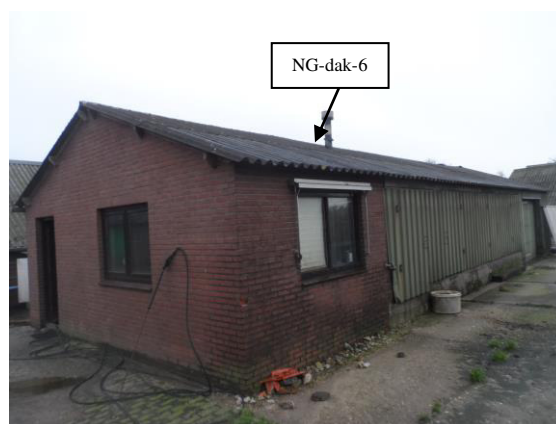
Foto 30: Geïnventarieerde schuur 7 met asbesthoudende golfplaat als dakbedekking vanuit westelijke richting gezien.
