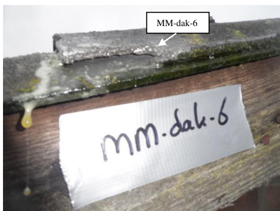
Foto 17: Asbesthoudende golfplaat als dakbedekking van schuur 4.
