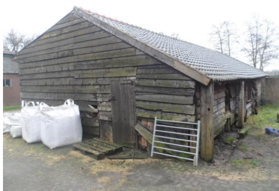
Foto 11: Geïventariseerde schuur 2 met aan deze zijde pannen als dakbedekking vanuit noordwestelijke richting gezien.
