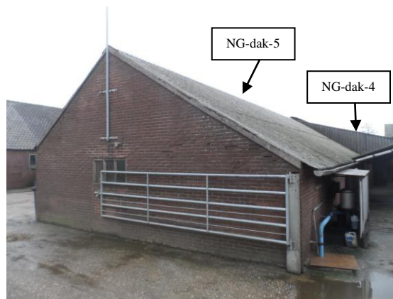
Foto 26: Geïnventarieerde schuur 6 met asbesthoudende golfplaat als dakbedekking en gedeeltelijk als gevelplaat vanuit noordwestelijke richting gezien.
