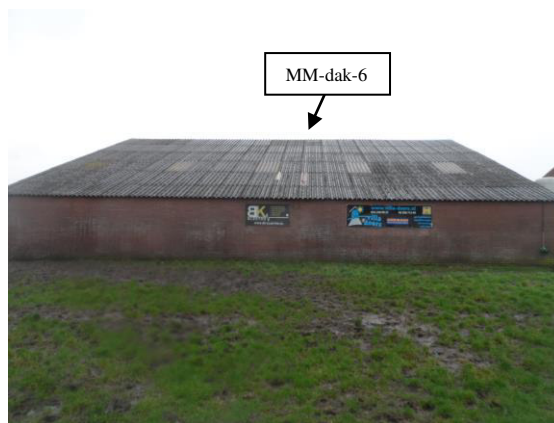
Foto 16: Geïntervieweerde schuur 4 met asbesthoudende golfplaat als dakbedekking vanuit zuidoostelijke richting gezien.
