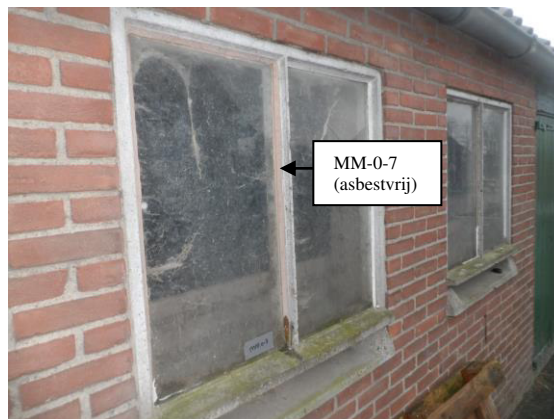
Foto 20: Asbestvrije stopverf in/aan raamkozijnen van schuur 5.
