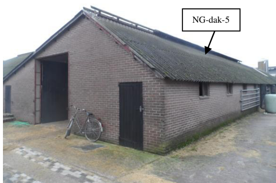
Foto 27: Geïnventarieerde schuur 6 met asbesthoudende golfplaat als dakbedekking vanuit zuidoostelijke
