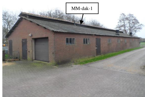
Foto 2: Geinventariseerde schuur 1 met asbesthoudende golfplaat als dakbedekking vanuit noordwestelijke richting gezien.
