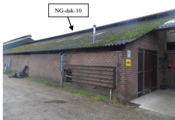
Foto 34: Geïntervieweerde schuur 10 met asbesthoudende golfplaat als dakbedekking vanuit noordoostelijke richting gezien.
