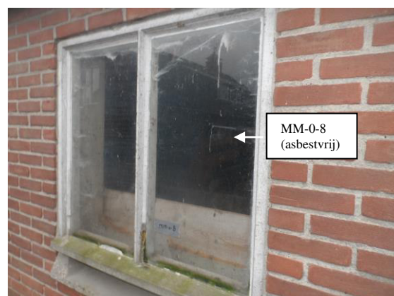
Foto 22: Asbestvrije stopverf in/aan raamkozijnen van schuur 5.
