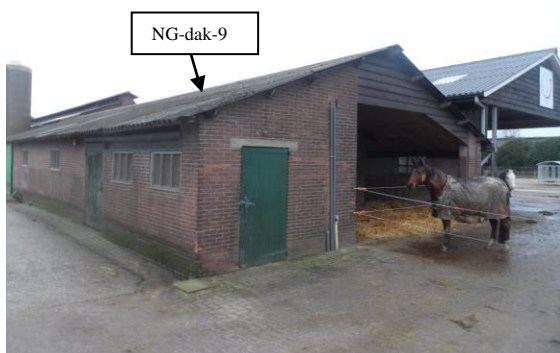
Foto 33: Geïntervieweerde schuur 9 met asbesthoudende golfplaat als dakbedekking vanuit noordoostelijke richting gezien
