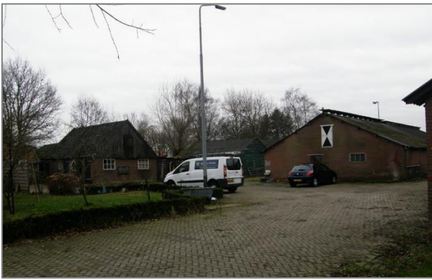
Afb. 1 | Overzicht met van links naar rechts gebouw 2, 3 en 4
