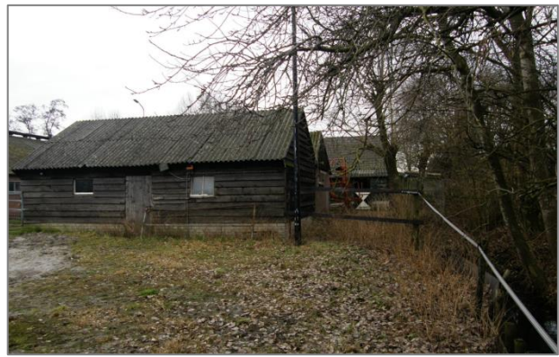
Afb. 2 | De kleine stal, gebouw 3.
