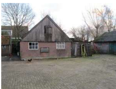
Foto 2: Aan huis vastzittende schuur (bouwvergunning 1)
