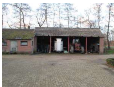
Foto 6: Wagenloods (bouwvergunning 8) met tanklocatie 2
