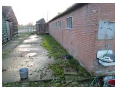
Foto 10: Stal (bouwvergunning 5 en 7) met tanklocatie 1
