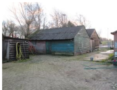
Foto 3: Stallen (bouwvergunning 2 en 4)
