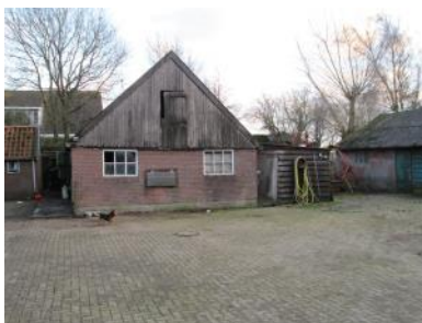
Foto 2: Aan huis vastzittende schuur (bouwvergunning 1)
