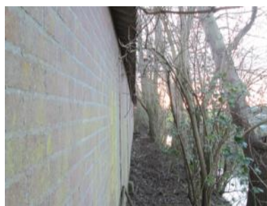
Foto 12: Onverharde strook onder asbestdak langs noordwestgrens
