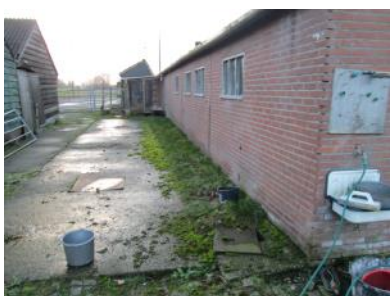
Foto 10: Stal (bouwvergunning 5 en 7) met tanklocatie 1
