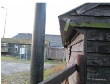
Foto 11: Asbestdak stal boven paardenpak
