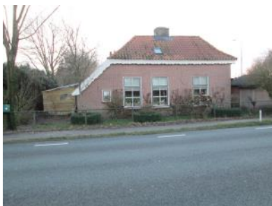
Foto 1: Woning met links de gedempte sloot
