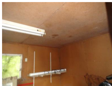
Schuur 6, aftimmering binnenzijde
