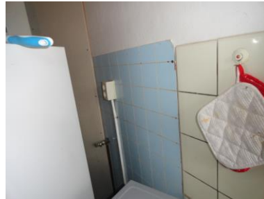
Woning, tegelboard, niet-asbesthoudend
