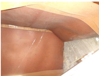
Woning, aftimmering binnenzijde
