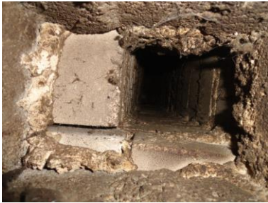
Woning, schoorsteenkanaal woonkamer
