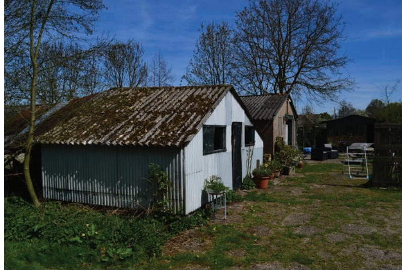
vlnr.: boerenschuur, kalver- schuur en kippenschuur
