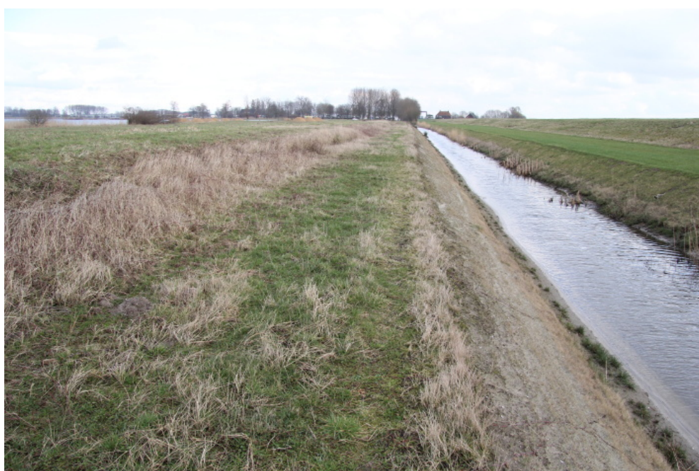
Figuur 5. Zuidrand van het gebied met rechts de Zeedijk en links de zandwal.
