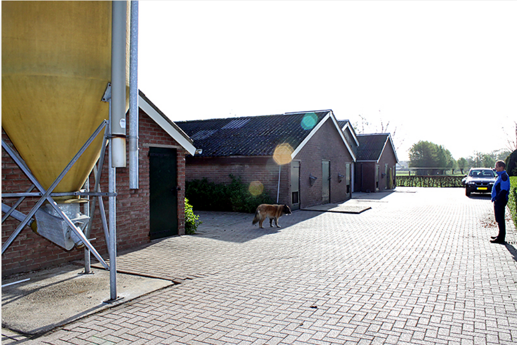
Zuidkant opstallen, zicht in oostelijke richting
