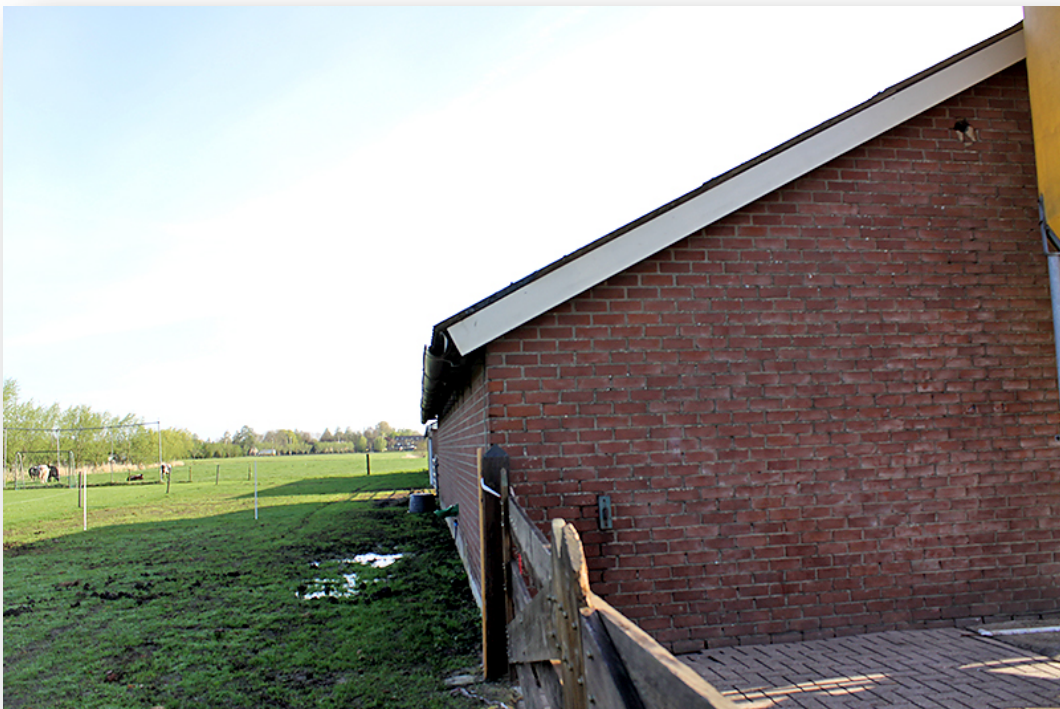
Westkant opstallen, zicht in noordelijke richting
