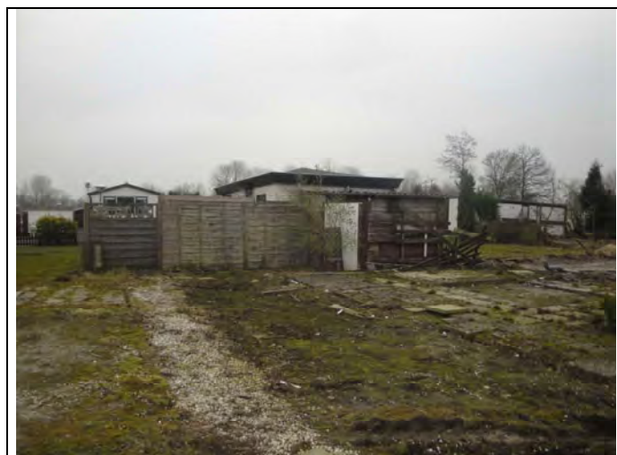
Foto 34: Visserslaan 3 (asbestverdachte golfplaat)
