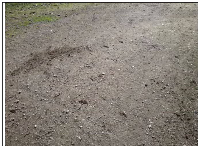
Foto 36: Parkeerterrein (verharding A)
