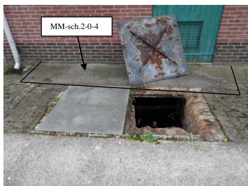
Foto 7: Stukje betonvloer t.p.v. afzuigpunt mestkelder met asbesthoudende golfplaat als verloren bekisting t.p.v. schuur 2.
