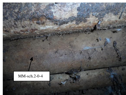
Foto 8: Asbesthoudende golfplaat als verloren bekisting (zie foto 7)
