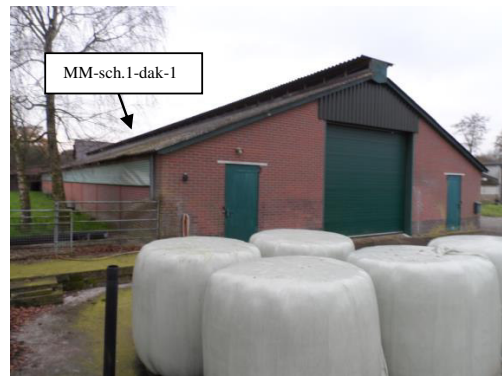
Foto 2: Geïnvventariseerde schuur 1 met asbesthoudende golfplaat als dakbedekking vanuit noordoostelijke richting gezien.
