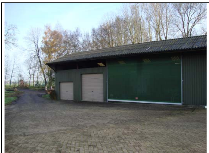
Foto 03: loods (met voormalige tank)
