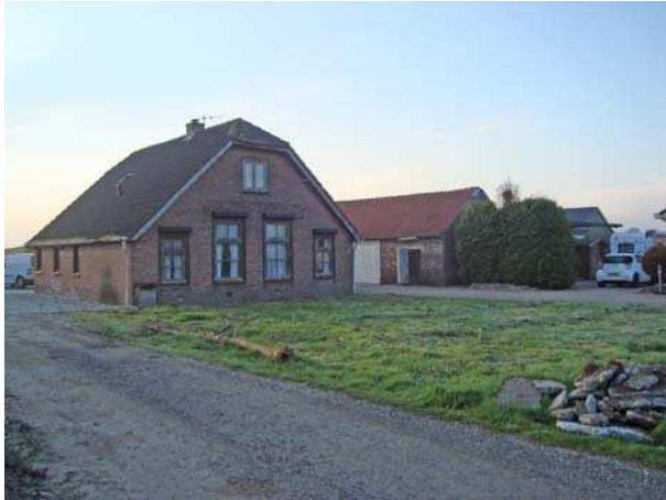
Foto 1. Oorspronkelijke woning (2) en rechts de huidige werkplaats (3).
