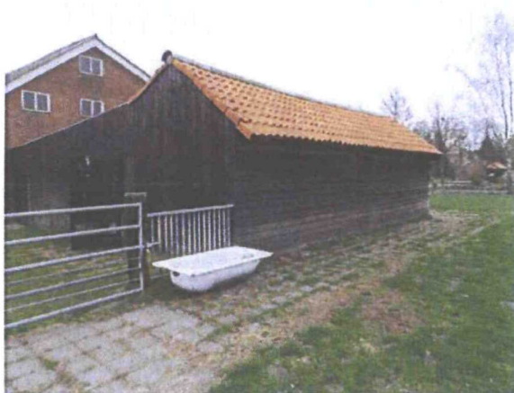
Foto 8: Geïnvventariseerde schuur 4 vanuit westelijke richting gezien.
