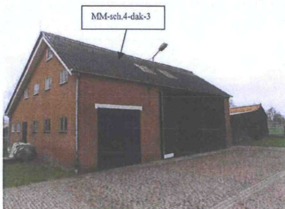
Foto 6: Geïntervieweerde schuur 4 met gedeeltelijk asbesthoudende golfplaat als dakbedekking vanuit noordelijke richting gezien.
