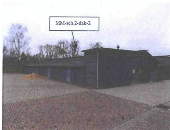
Foto 4: Geïntervieweerde schuur 2 met asbesthoudende golfplaat als dakbedekking vanuit zuidelijke richting gezien.
