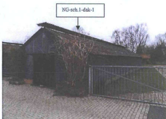
Foto 3: Geïnvesterde schuur 1 met asbesthoudende golfplaat als dakbedekking vanuit zuidoostelijke richting gezien. (tevens rechts geïnvesterde mestkelder zichtbaar)
