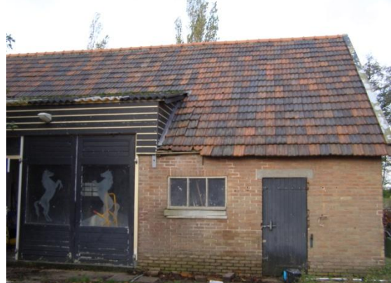
Afbeelding 4: de deels te slopen werk/opslagschuur.
