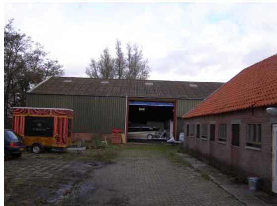
Afbeelding 3: de te slopen opslagloods.
