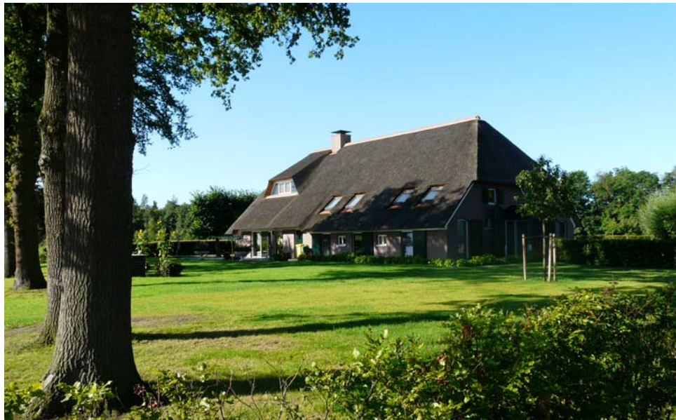
Boerderij de Klingkenberg (recent gerenoveerd)
