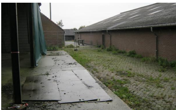
Foto 5: Ruimte tussen schuren met beton- en klinkerverharding
