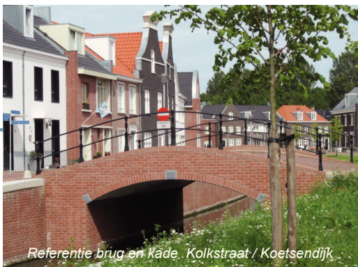
Referentie brug en kade Kolkstraat / Koetsendijk
