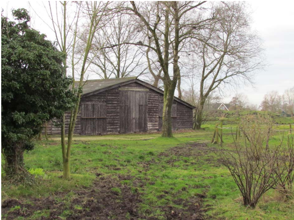
Schuur S5 is een van de drie schuren die zal worden gesloopt
