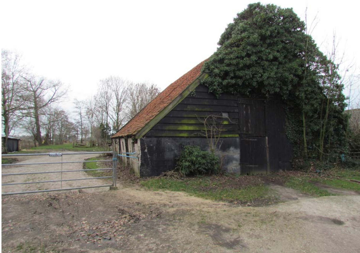
De grote klimop aan de gevel van schuur S2 is van belang als rust- en slaapplek voor huismussen
