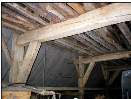
Fig. 85 Ankerbalkgebinten westzijde met slietenvloer
