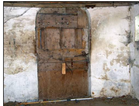
Fig. 49 Opgeklampte mestdeur achtergevel
