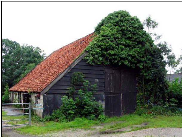
Fig. 77 Overzicht noordgevel veestal
