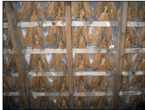
Fig. 76 Kapconstructie met strodokken
