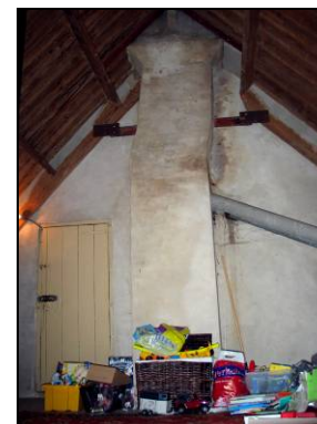
Fig. 57 Schoorsteenkanaal
