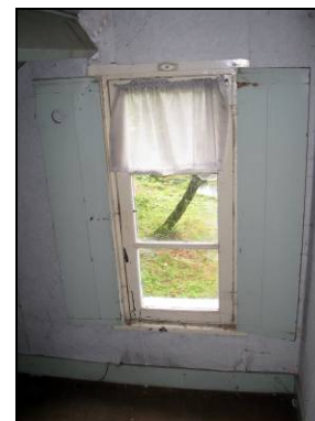
Fig. 34 Venster met blinden
