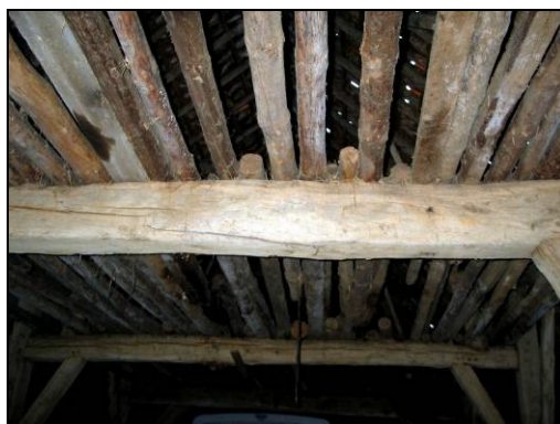
Fig. 86 Hooizolder met slietenvloer
