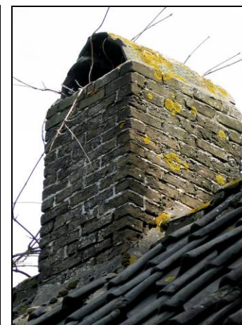
Fig. 66 Schoorsteen met pullenloper
