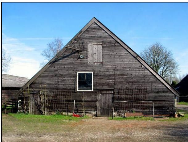
Fig. 79 Overzicht zuidgevel veestal
