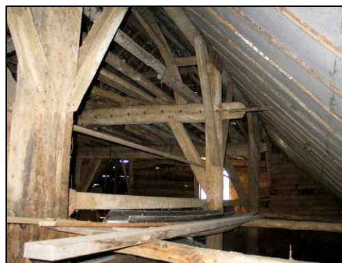
Fig. 87 Ankerbalkgebinten westzijde veestal
