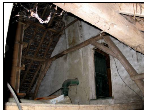
Fig. 52 Kap deel met toegang naar voorhuis
