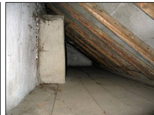
Fig. 35 Bergruimte met rookkanaal.
