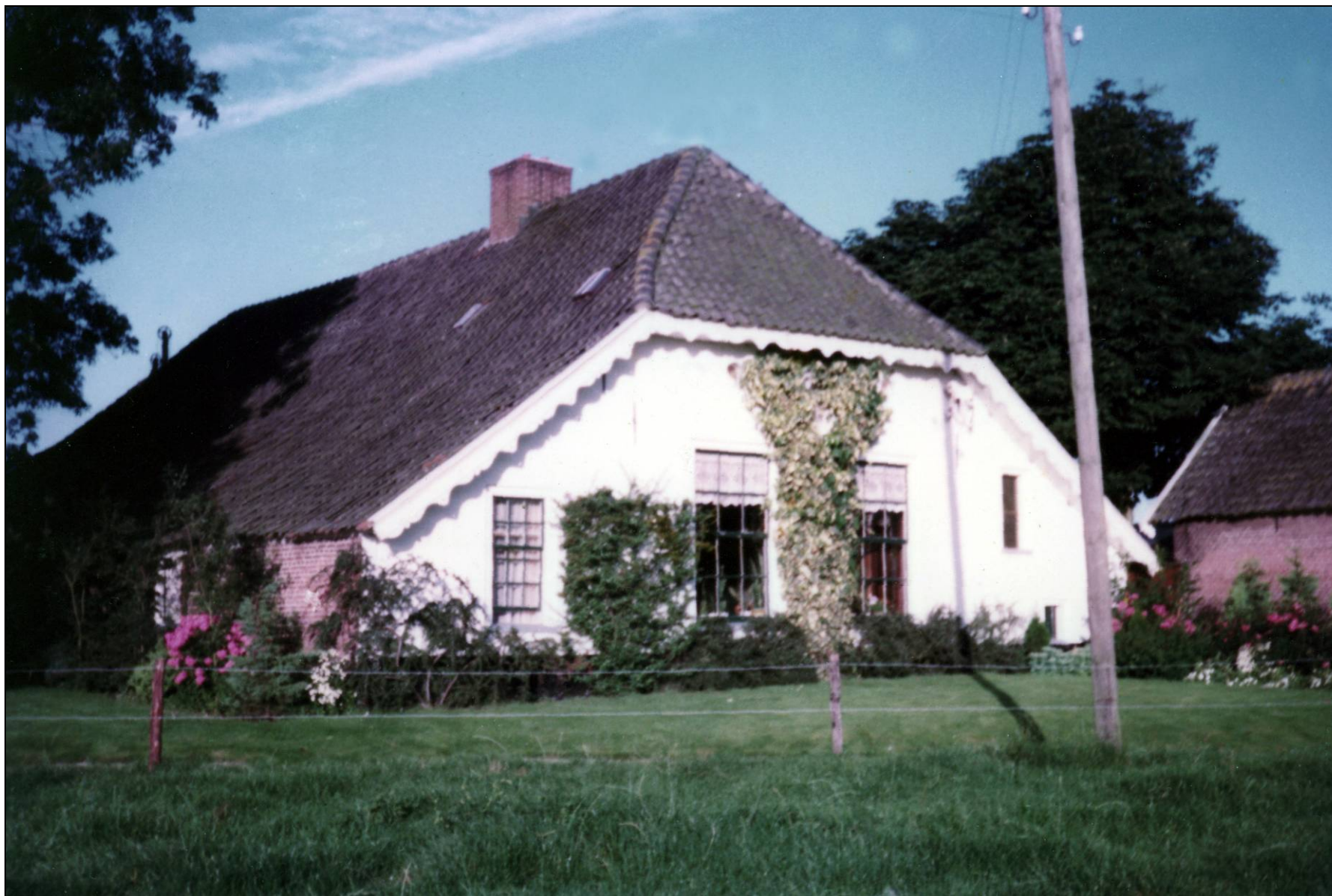
Fig. 117 Voorgevel Nordengoed in 1982. Bron: Fam. Davelaar, Nijkerk
