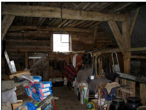
Fig. 81 Overzicht veestal naar de zuidgevel
