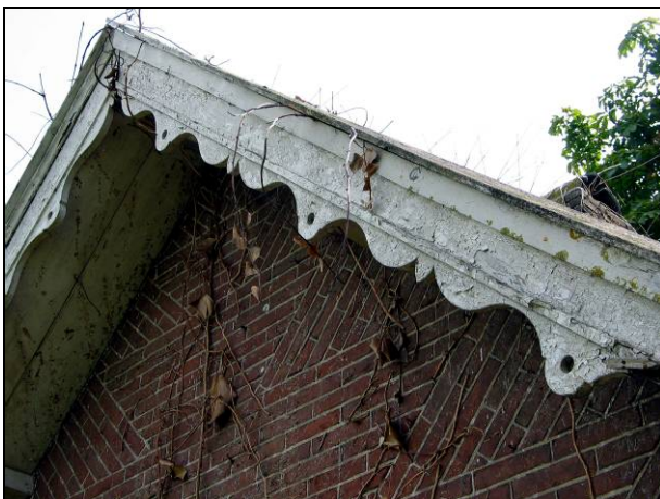
Fig. 68 Detail gesneden windveren en vlechtingen
