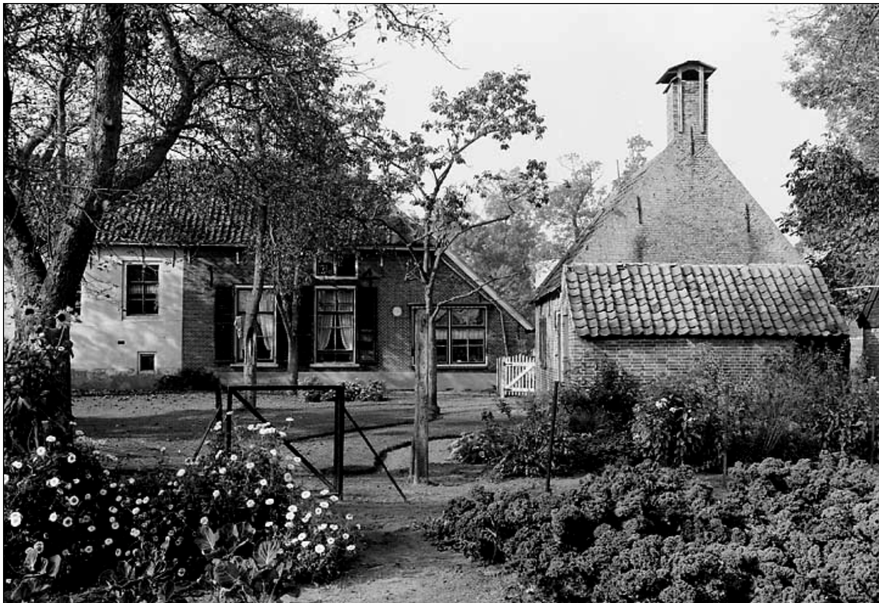
Fig. 119 De boerderij 'Hammetjesgoed' met jaartalankers "1747" en bakhuis in 1965. Deze afbeelding is opgenomen om een mogelijke voorganger van het huidige bakhuis te illustreren. Bron: Rijksdienst voor het Cultureel Erfgoed, Amersfoort Neg.nr. 103.406
