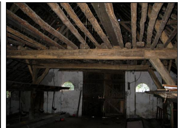
Fig. 44 Overzicht deel naar de achtergevel met tasliggers
