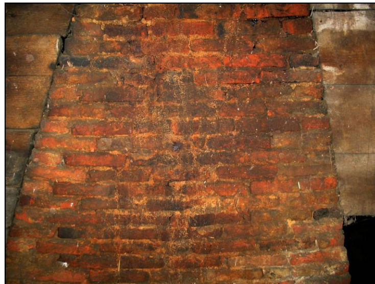
Fig. 6 Schoorsteenkanaal op de zolderverdieping van het bakhuis
