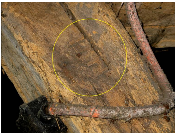
Fig. 7 Gehakt telmerk IIII in het bedrijfsgedeelte
