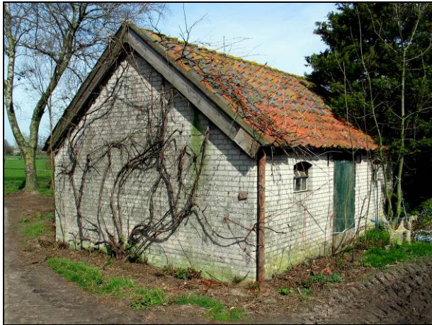
Fig. 89 Overzicht zuidoostzijde washok
