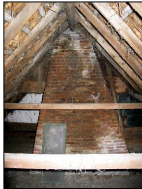
Fig. 75 Schoorsteenkanaal
