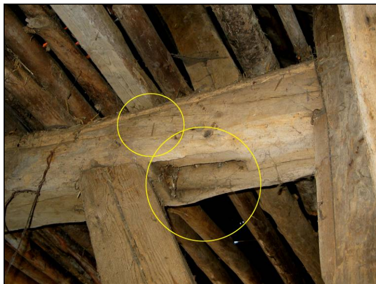
Fig. 8 Gehakt telmerk I op secundair gebruikte dekbalk in de veestal
