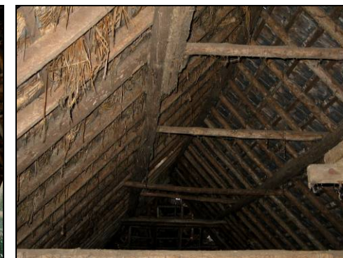
Fig. 54 Overzicht kapconstructie bedrijfsgedeelte
