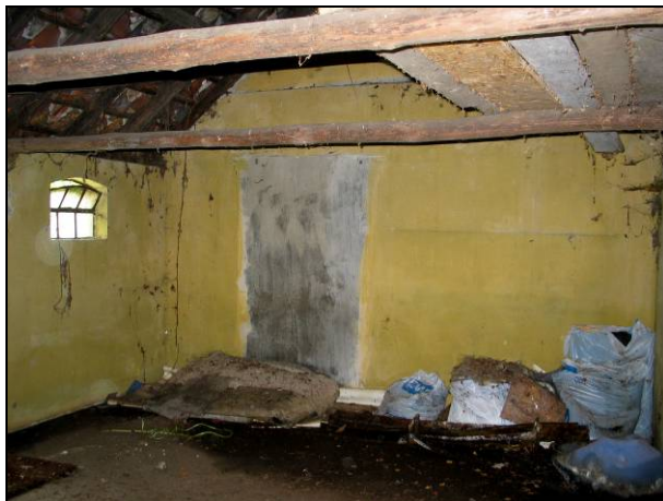
Fig. 92 Overzicht interieur naar het zuiden
