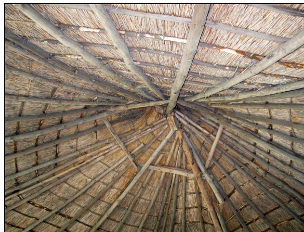
Fig. 96 Kapconstructie met lanen en sporen
