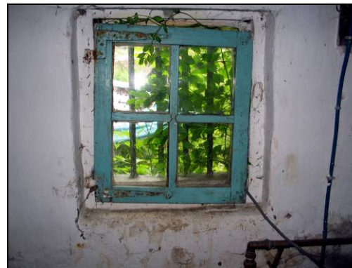
Fig. 26 Kelderlicht met raamgehangen
