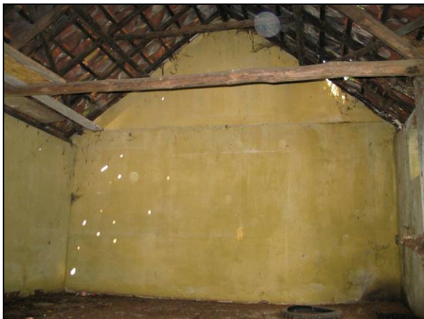
Fig. 91 Overzicht interieur washok naar het noorden
