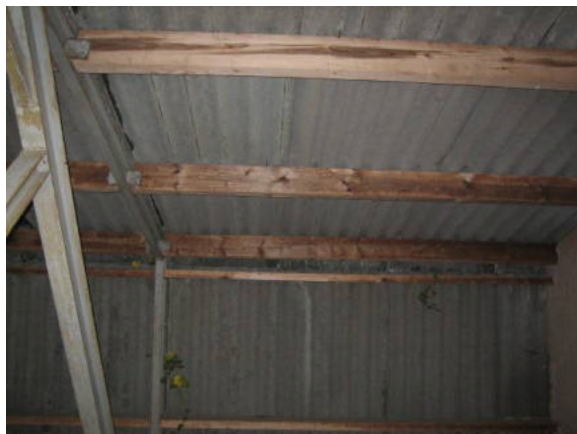
Foto 3: dakconstructie van de kapschuur
