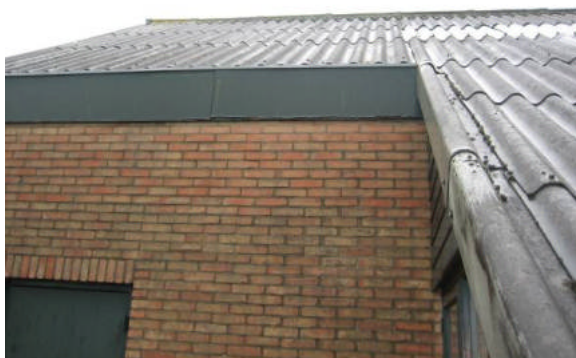
Foto 4: aanzicht loods met boeiboord en golfplaten
