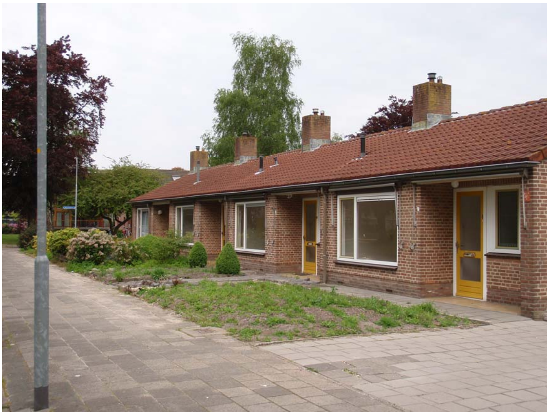
Figuur 1.2 Foto van het zuidelijke huizenblok gelegen aan de Parklaan (drs. C.C. Kalisvaart, 26-05-2010). Dit huizenblok zal in de toekomst worden gesloopt, waarna er nieuwe appartementen gerealiseerd zullen worden op vrijwel dezelfde locatie als de huidige bebouwing.
