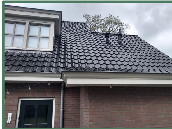
Overzicht dak bedrijfswoning
