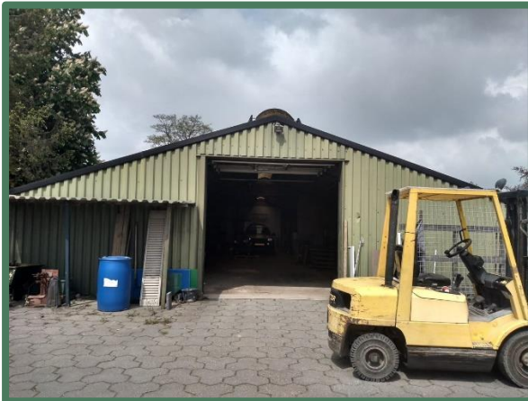
Zuidzijde van de zuidelijke loods
