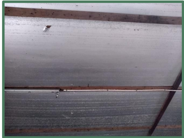
Onderzijde dak zuidelijke loods
