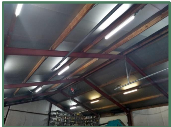
Onderzijde dak zuidelijke loods
