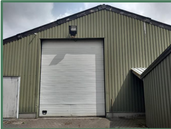
Westzijde van de noordelijke loods
