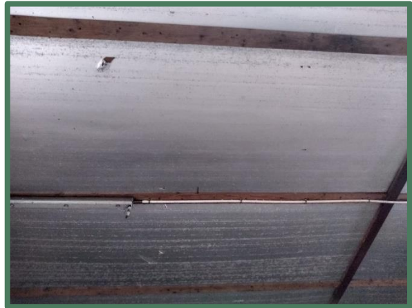
Onderzijde dak zuidelijke loods
