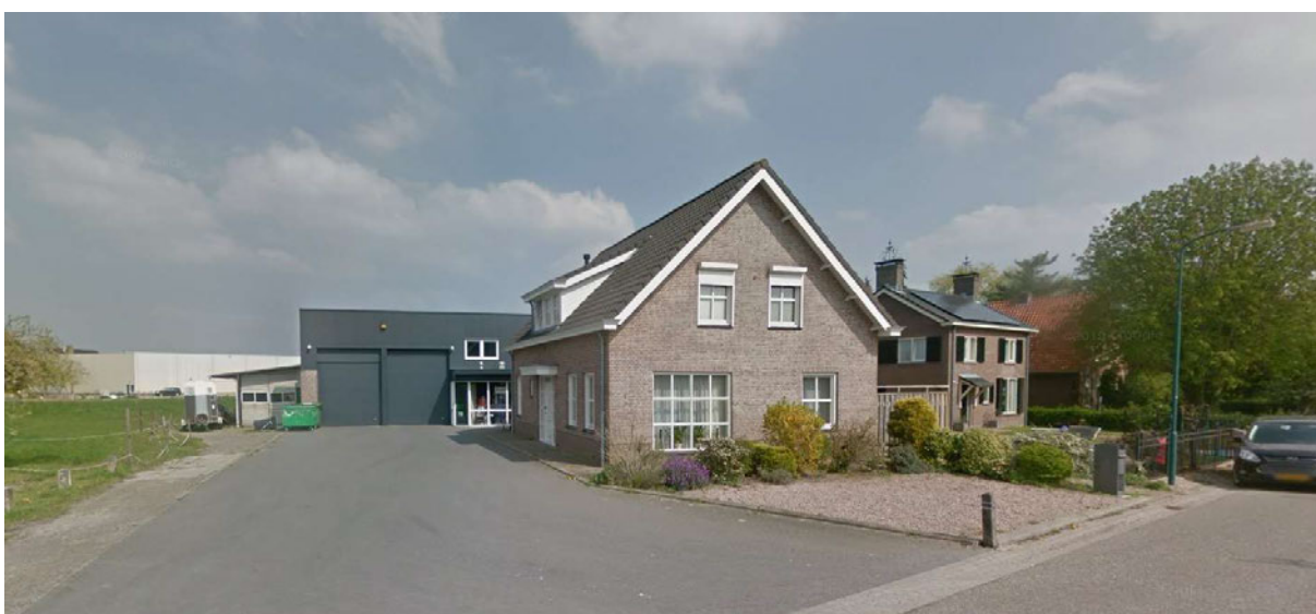
Afbeelding 9+10: bedrijfswoningen op het voorerf, bedrijfspanden op het achtererf.
