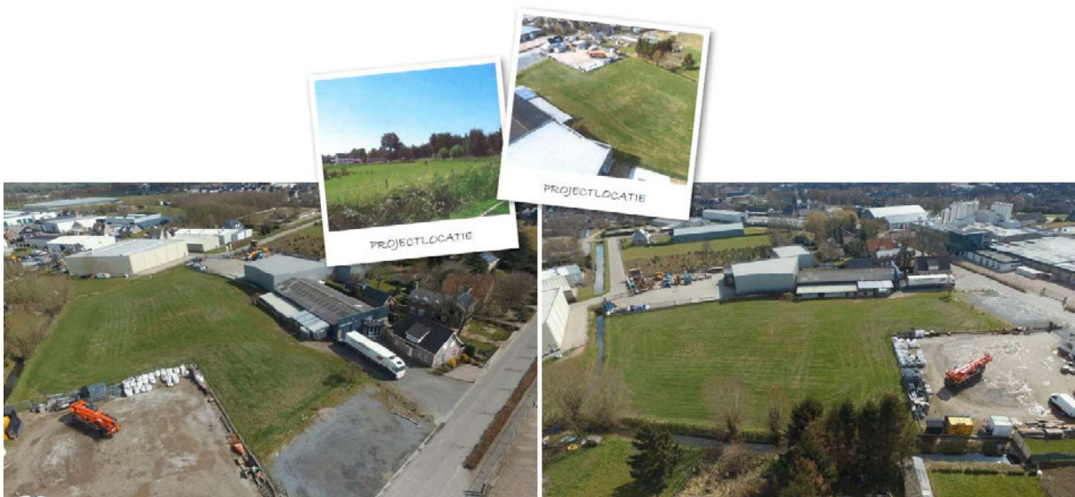
Afbeelding 2: foto's bestaande situatie.
