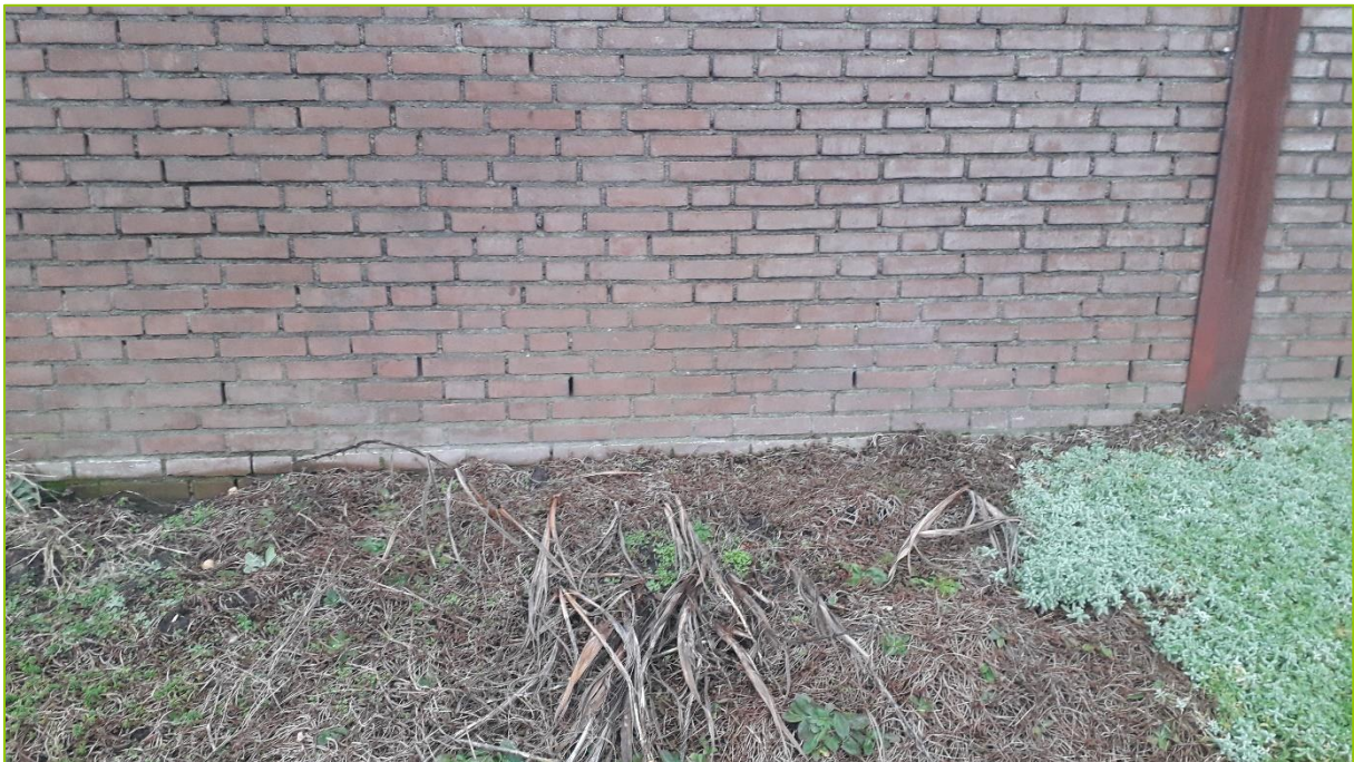
De aanwezige openingen in de bebouwing leiden niet tot geschikte verblijfplaatsen ten aanzien van beschermde gebouwbewonende soorten
