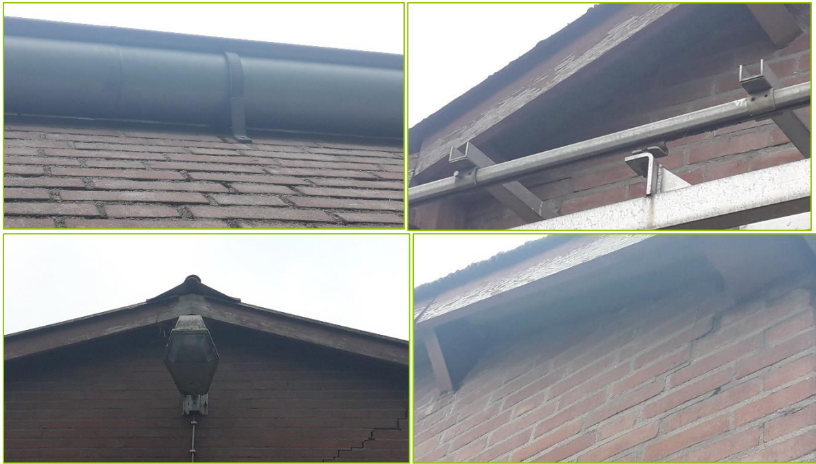
Figuur 5 Details van de dakranden. Aangezien het dak uit enkel-laags golfplaten bestaat, is er geen dakbeschot of andere ruimte onder het dak om onder weg te kruipen. Eventuele kleine spleten aan de bovenkant leiden naar achterliggende zolderruimtes (zie figuur 4)
