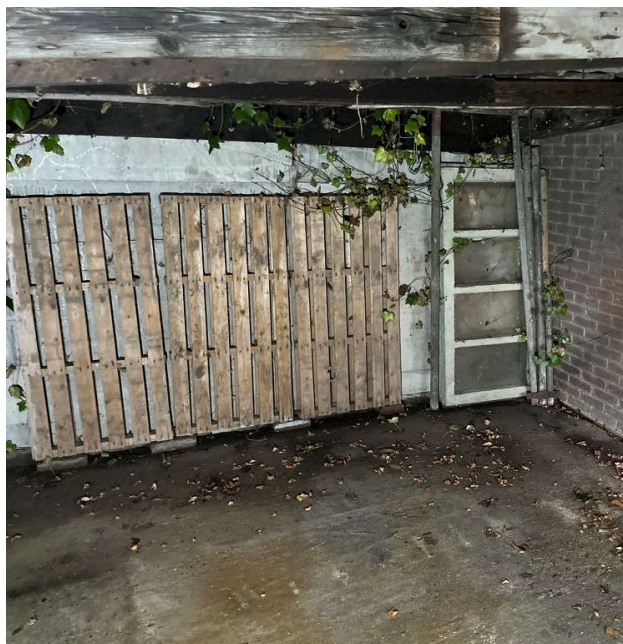
Binnenzijde opslag gebouw links
