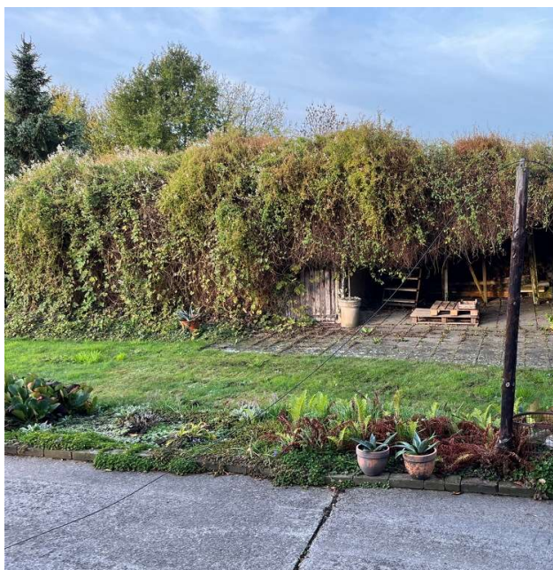
Voorzijde stal / opslag gebouw links
