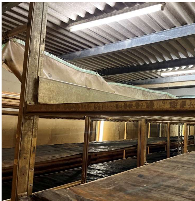
Binnenzijde gebouw rechts, cel
