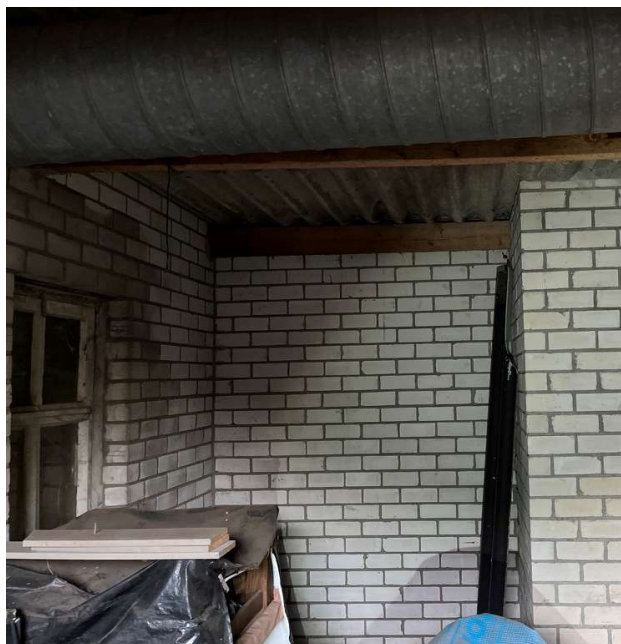
Binnenzijde opslag gebouw links, gang
