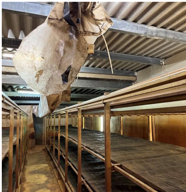
Binnenzijde gebouw rechts, cel
