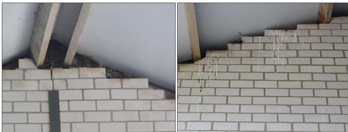
Foto 9 en 10. Nestaanzet in de nokken van de kapschuur.
