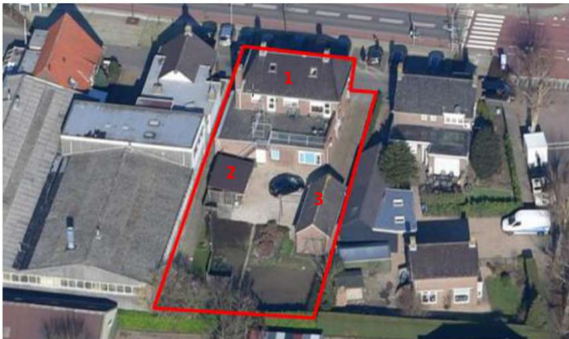
Figuur 4: luchtfoto onderzoekslocatie met het pand (1), de kapschuur (2) en garage (3).
