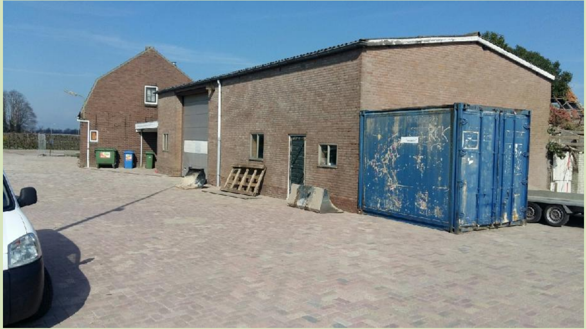
Figuur 2.4 Foto plangebied; bedrijfsbebouwing
