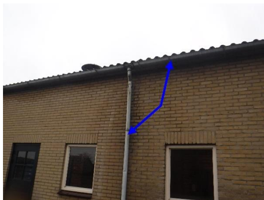
Foto 34 | Pvc en zinken hemelwaterafvoeren
