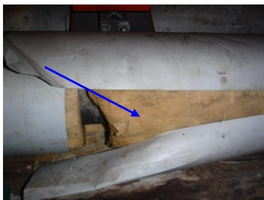
Foto 30 | Hard schuimisolatie rondom leidingen
