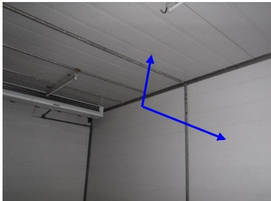
Foto 21 | Staalplaat wanden en plafond
