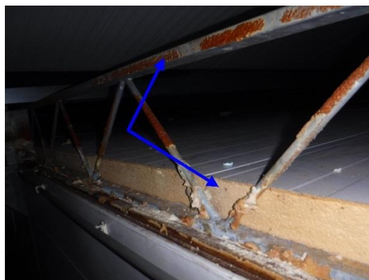
Foto 24 | IJzeren spanten met isolatieplaten
