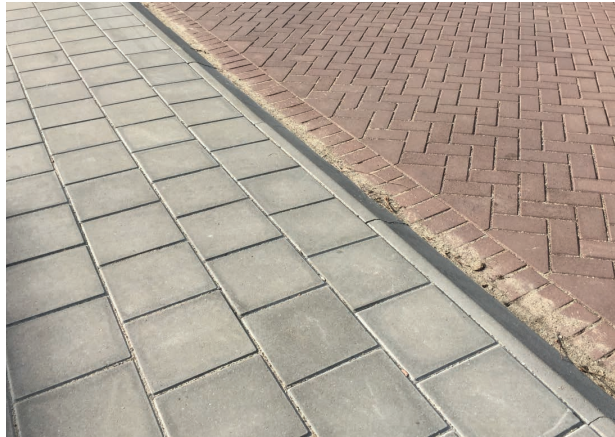
Rijbaan in keperverband en trottoirtegels in halfsteensverband (bron: Giverbo)
