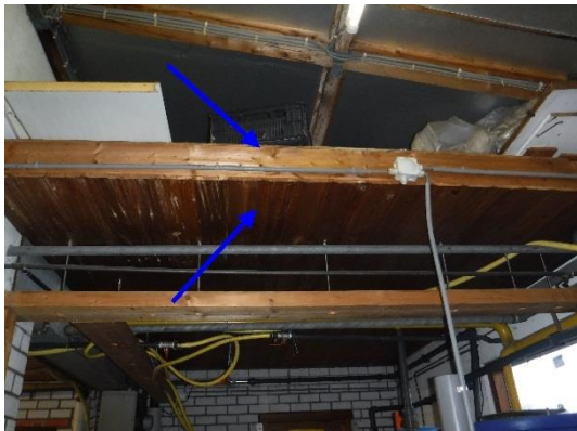
Foto 29 | Houten plafond en vloer
