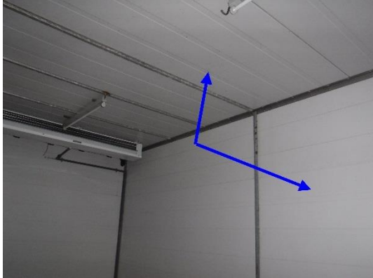
Foto 21 | Staalplaat wanden en plafond
