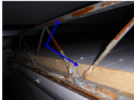
Foto 24 | IJzeren spanten met isolatieplaten
