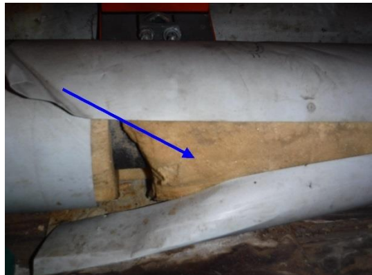
Foto 30 | Hard schuimisolatie rondom leidingen
