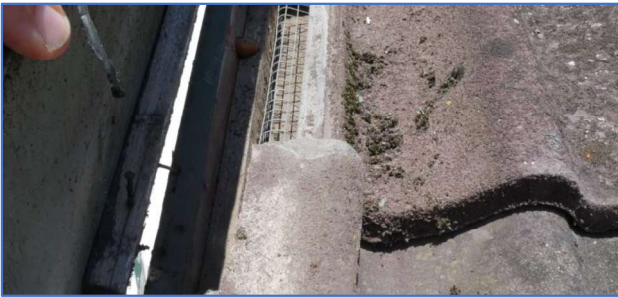
Foto 11 planken windveren met gaasafdeling
