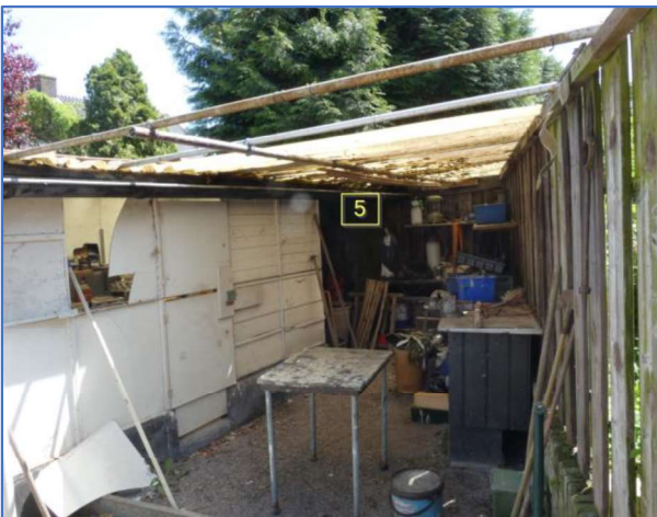
Foto 30 gebouw 5 afdak en schuurtje
