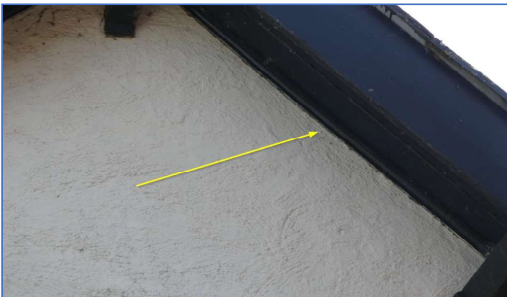
Foto 49 Dak-overstek gebouw 1 a W
