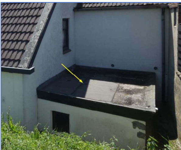
Foto 8 bitumen platte dak
