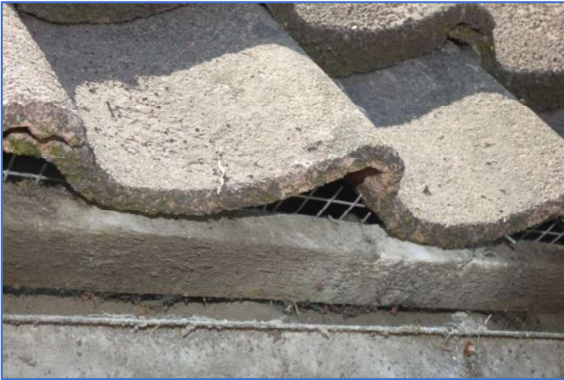
Foto 9 en 10 gaas onder 1e pannen gebouw 1a
