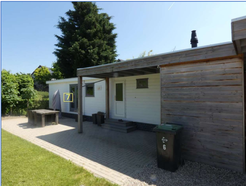
Foto 37 bouwwerk 7, woning nr. 6a
