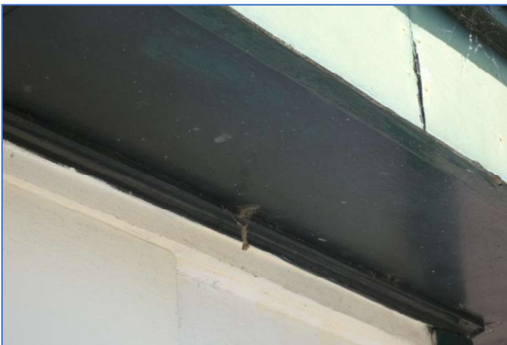
Foto 51 Onderzijde balkon Z naast gebouw 1b
