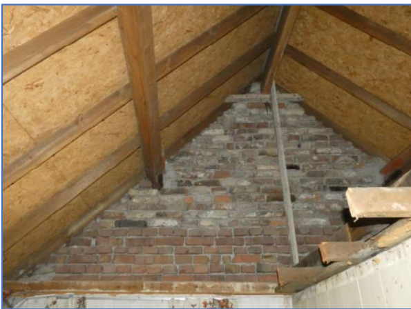
Foto 6 en 7 Ondersloten kap gebouw 1a
