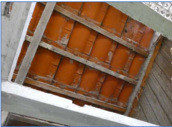
Foto 19 niet onderschoten dakpannen
