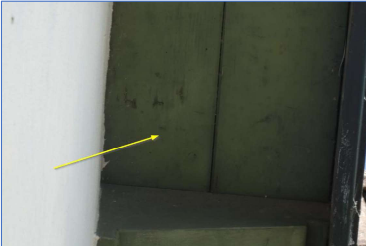
Foto 50 Dak-overstek gebouw 1b O
