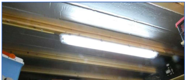
Foto 36 isolatie tegen dak berging
