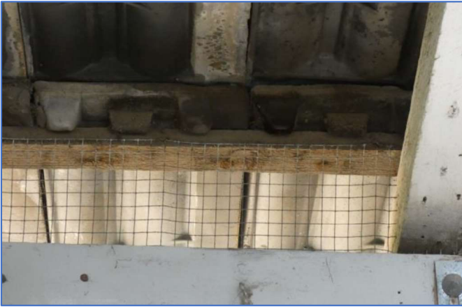
Foto 27 gaasafdicthing wanden en dakpannen
