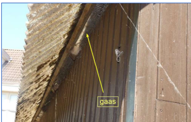
Foto 21 Geen goot W-zijde en gaasafdichting wanden en dak
