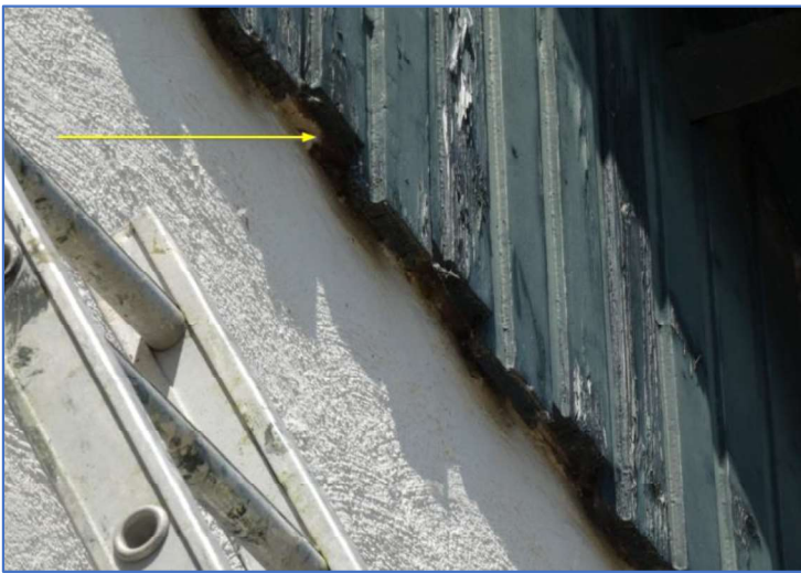
Foto 48 afgedichte topgevelbekleding gebouw 1a gevel oostzijde
