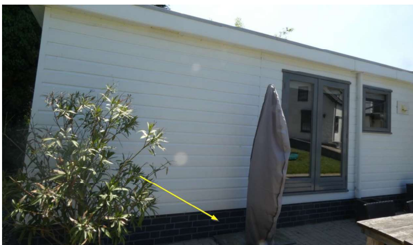
Foto 38 geheel afgedichte ruimte onder woning 6a.
