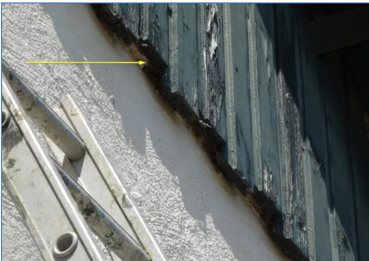
Foto 48 afgedichte topgevelbekleding gebouw 1a gevel oostzijde
