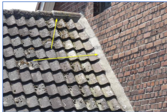
Foto 13 aansluiting gebouw 1 b, dak
