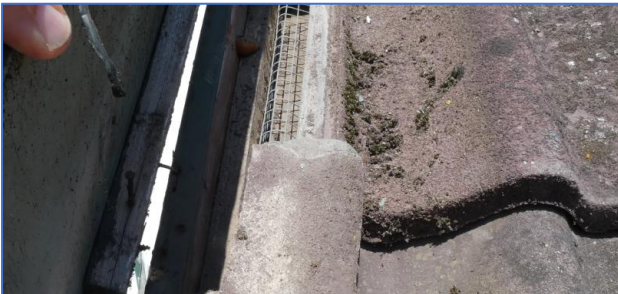
Foto 11 planken windveren met gaasafdeling
