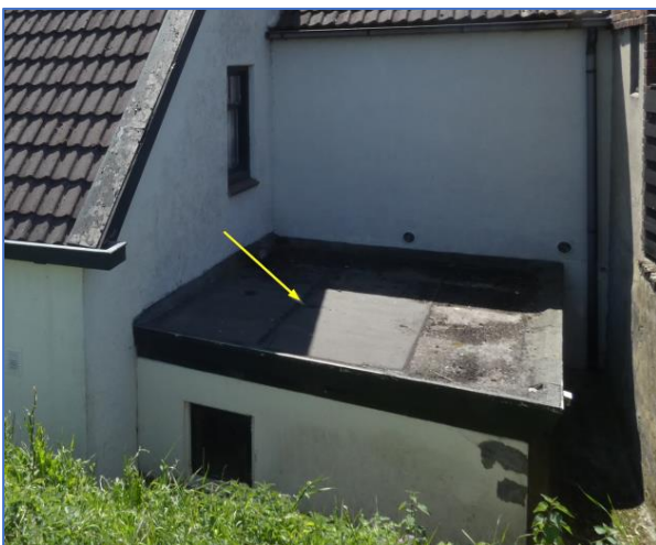
Foto 8 bitumen platte dak
