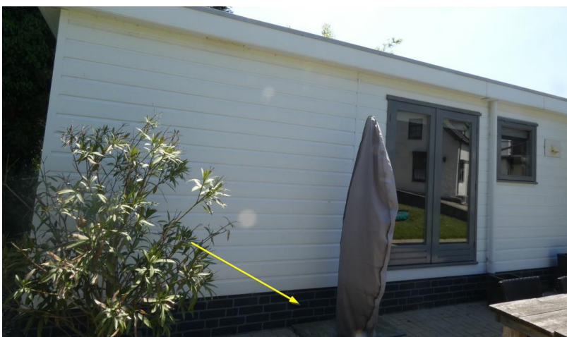
Foto 38 geheel afgedichte ruimte onder woning 6a.
