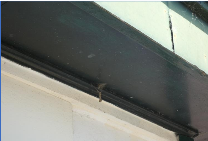
Foto 51 Onderzijde balkon Z naast gebouw 1b
