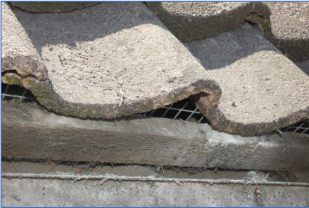
Foto 9 en 10 gaas onder 1e pannen gebouw 1a
