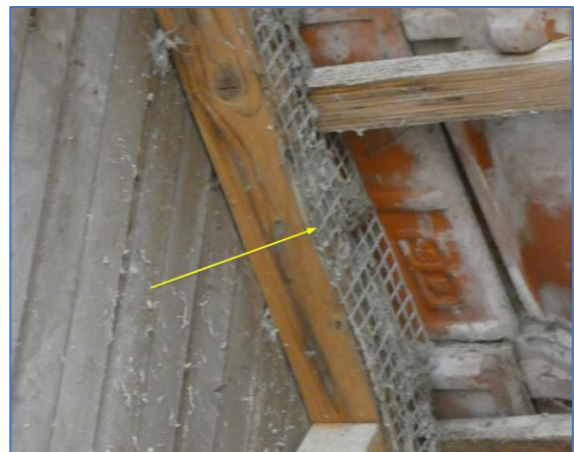
Foto 21 Geen goot W-zijde en gaasafdichting wanden en dak
