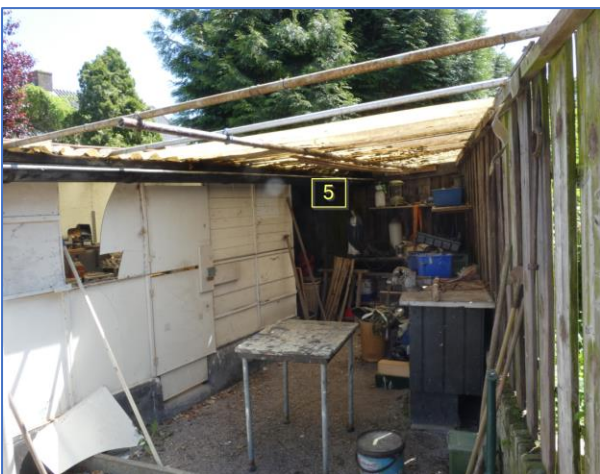
Foto 30 gebouw 5 afdak en schuurtje
