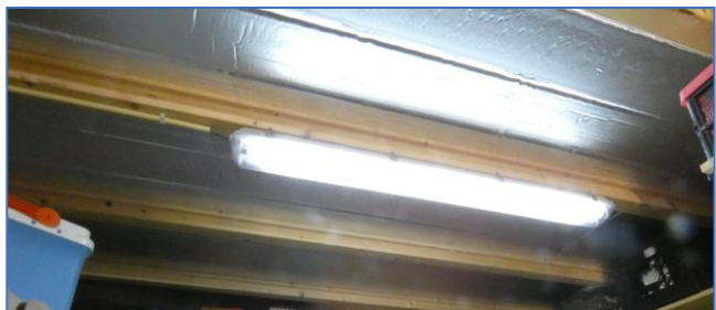
Foto 36 isolatie tegen dak berging
