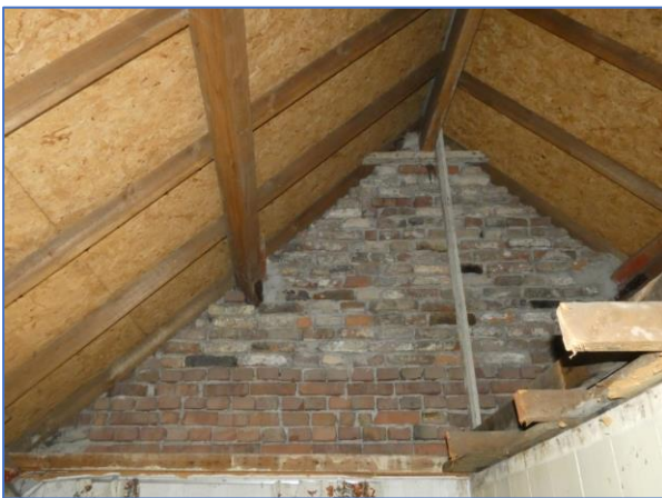
Foto 6 en 7 Ondersloten kap gebouw 1a
