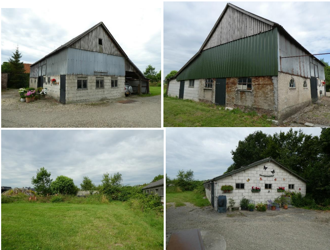
Afbeelding 3 t/m 6: De te slopen bebouwing. Bron: BNL advies. Datum: 13-07-2022
