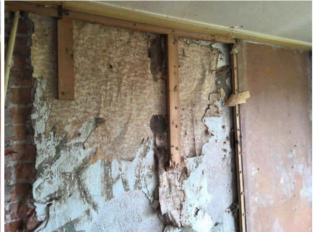
Foto 23 | Foto voor bron Plaatmateriaal (restanten en rondom spijkers)
