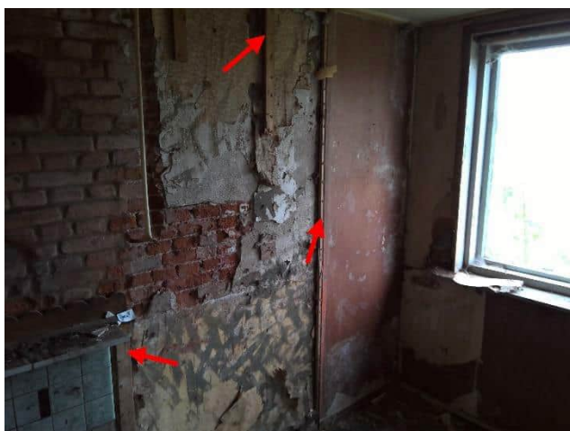
Foto 20 | Foto voor bron Plaatmateriaal (restanten en rondom spijkers)
