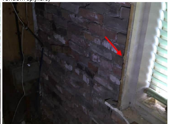
Foto 27 | Foto voor bron Plaatmateriaal (restanten en rondom spijkers)
