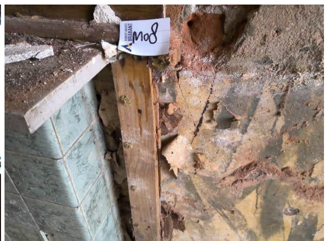
Foto 21 | Foto voor bron Plaatmateriaal (restanten en rondom spijkers)
