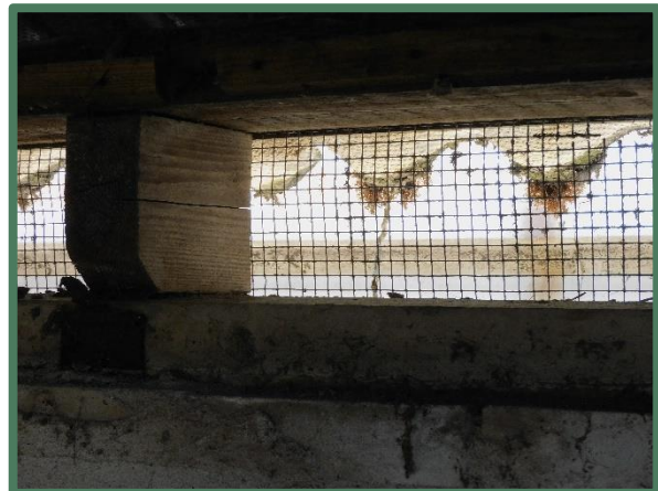
muurplaat op spouw met luchtinlaat
