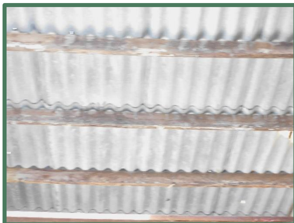
Verwijderde isolatie met onderzijde dak
