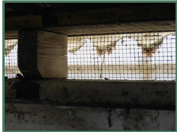
muurplaat op spouw met luchtinlaat
