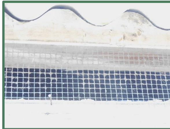
Afgesloten dakrand en luchtinlaat
